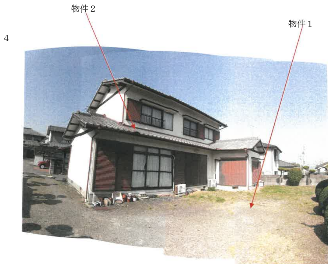
物件 2 建物の南側及び西側の状況
