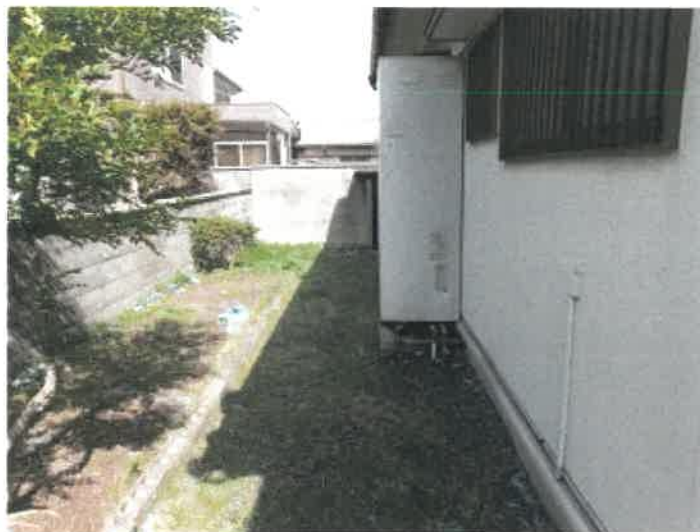
物件 2 建物北側の状況
