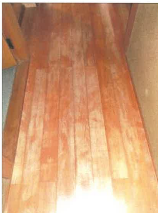
物件2 建物の1階玄関前廊下の状況
