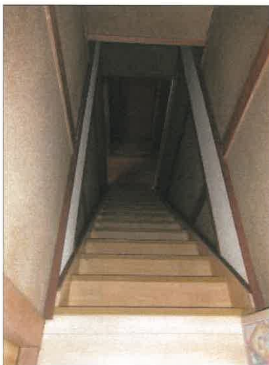
物件 2 建物の階段の状況
