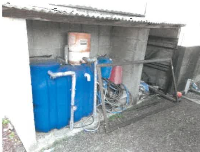
物件2 未登記附属建物の状況
