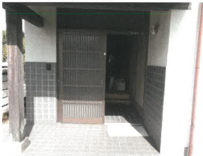
物件 2 建物玄関付近の状況
