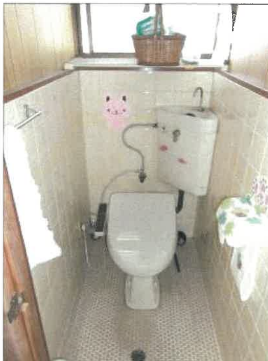
物件 2 建物の 1 階トイレの状況
