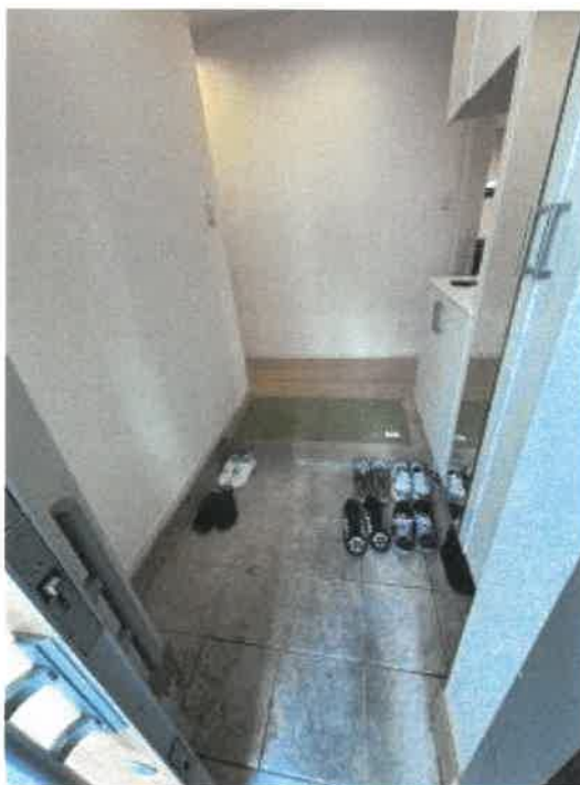
物件2 玄関内の状況
