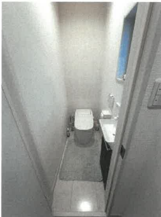
物件 2 1 階トイレの状況
