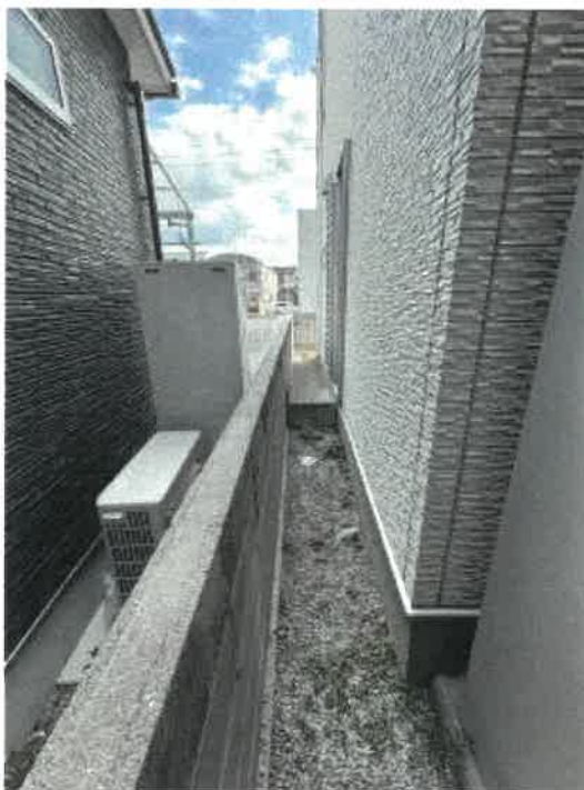
物件1 東側の状況
