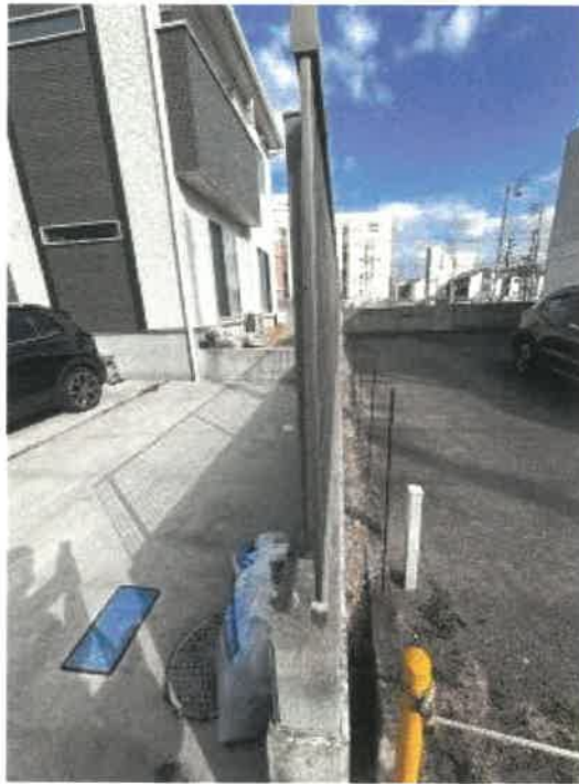
物件1 南側の状況
