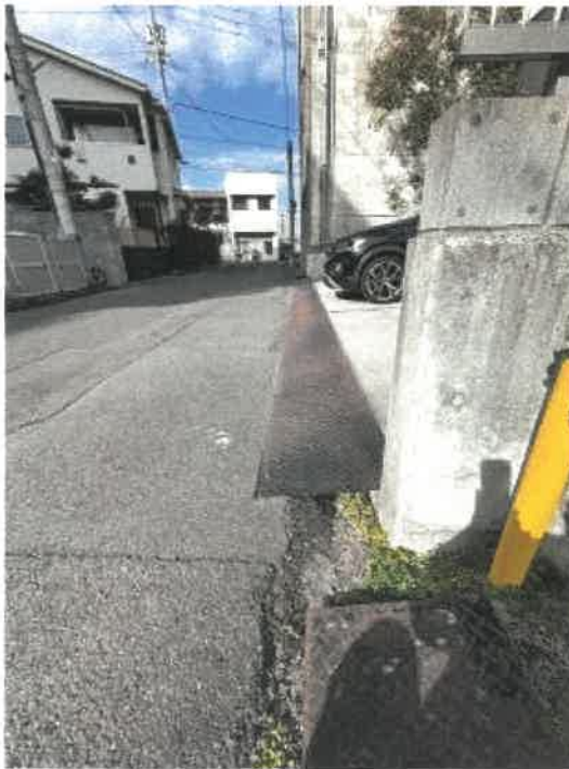
物件1 西側の状況
