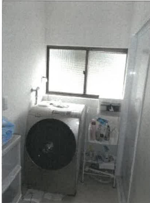
物件2 建物の1階洗面脱衣所の状況
