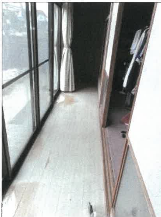
物件2建物の1階西側南和室の南側廊下の状況
