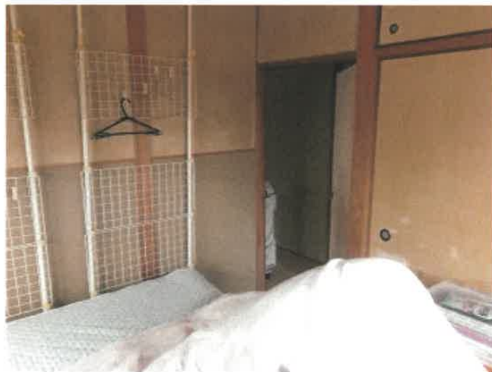
物件 2 建物の 1 階北東角和室の状況
