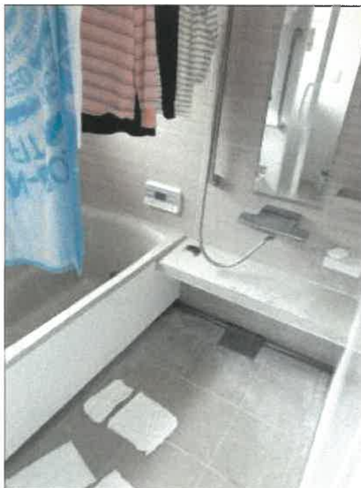
物件2 建物の1階浴室の状況
