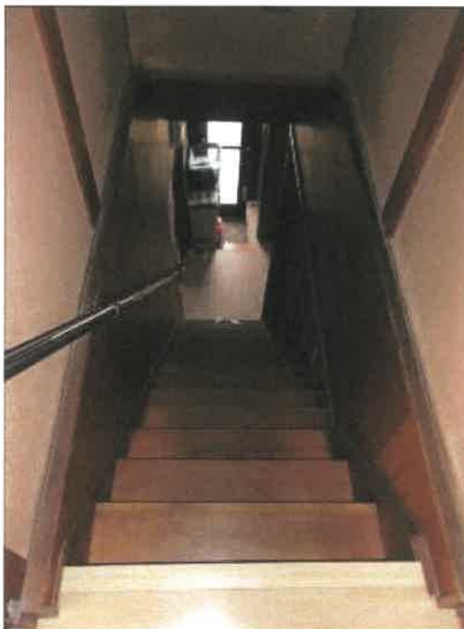
物件 2 建物の階段の状況
