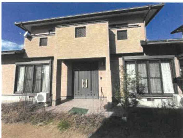
物件 2 土地上の目的外建物 1 の状況
