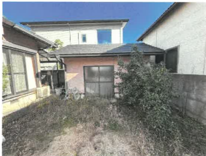
物件 1、 2 土地上の目的外建物 2 の状況
