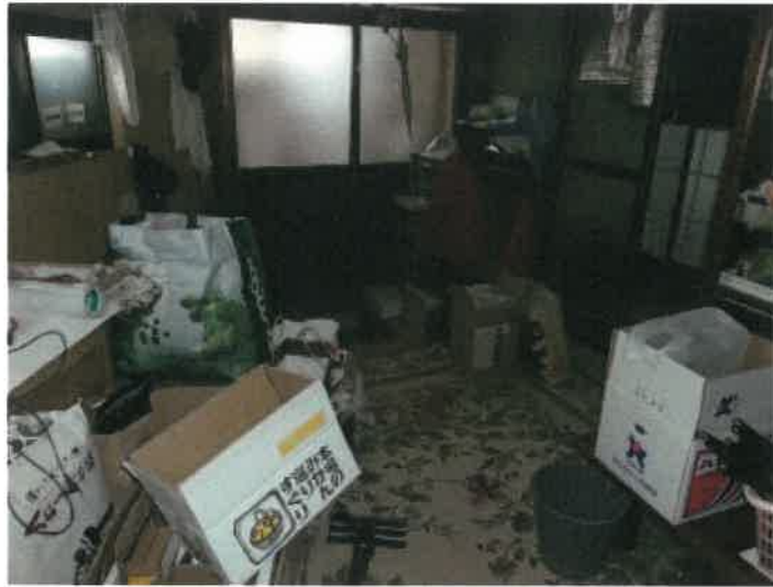
物件 3 主である建物東端洋室（増築部分）の状況
