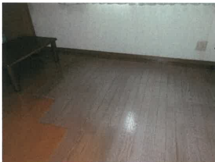
物件 2 建物の 2 階中の洋室の状況
