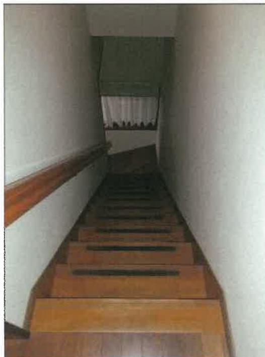
物件 2 建物の階段の状況
