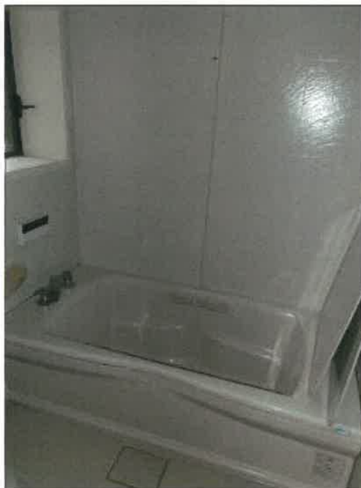
物件 2 建物の 1 階浴室の状況
