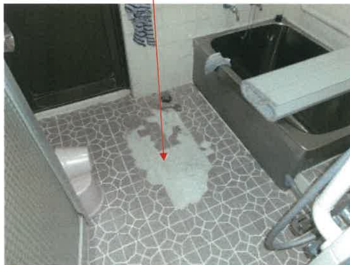
物件 3 主である建物浴室の状況
