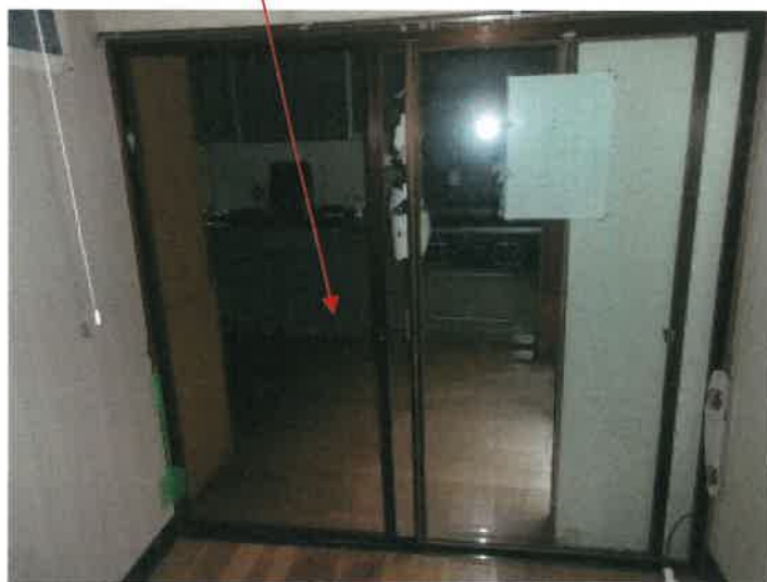
物件3主である建物北端ホール（廊下）部分の状況（増築部分） （物件2建物と物件3主である建物の行き来できるガラス戸）
