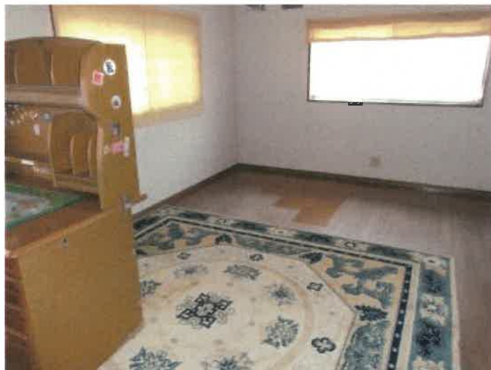
物件 2 建物の 2 階北端洋室の状況
