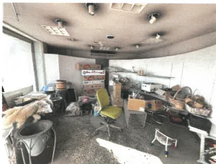
物件3 1階店舗（作業所）内の状況
