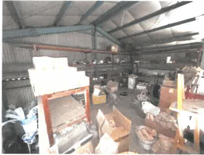
物件3 附属建物2階の状況
