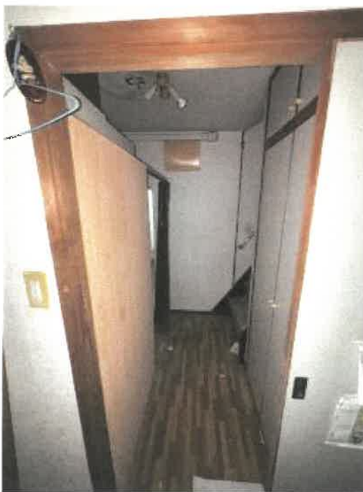
物件3 1階廊下（ホール）の状況
