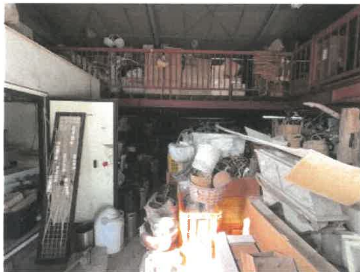
物件3 附属建物1階の状況
