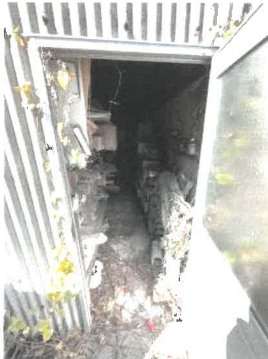
物件3 附属建物1階北側倉庫の状況
