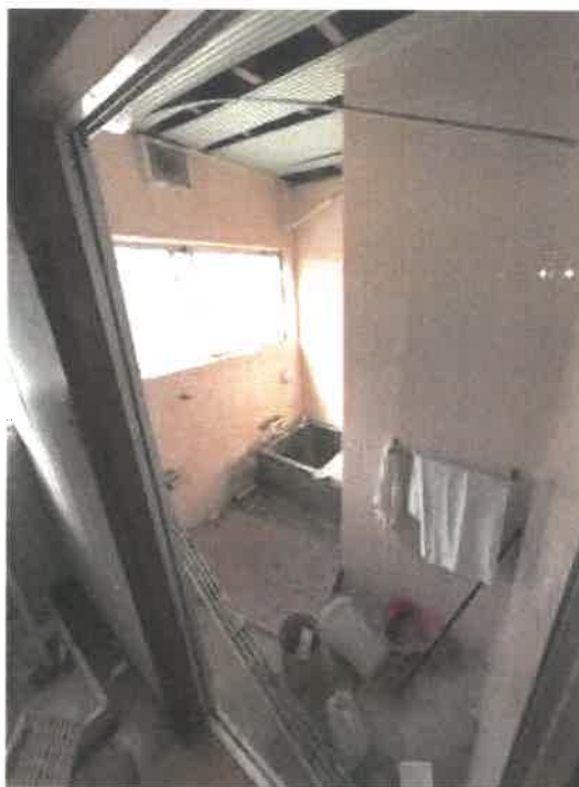
物件3 1階浴室の状況
