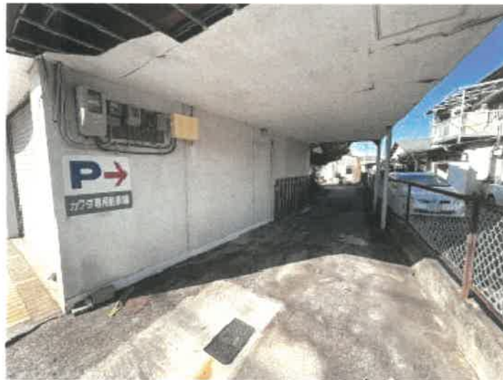
店舗北東側駐車場の状況
