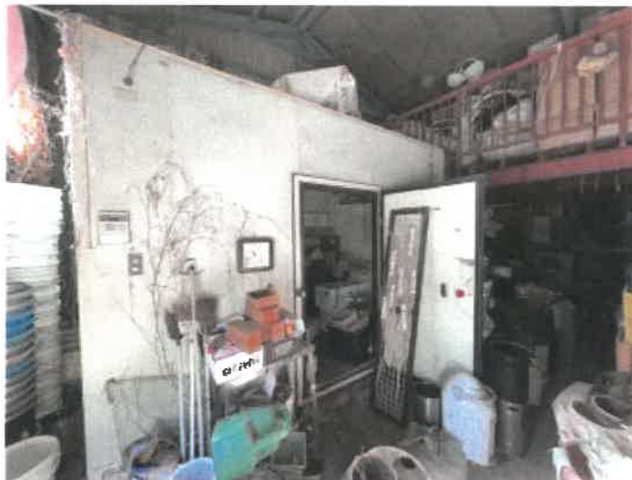
物件 3 附属建物 1 階の冷蔵庫の状況
