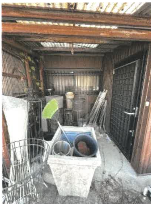
物件3 居宅部分の入口付近の状況 (未登記増築部分)
