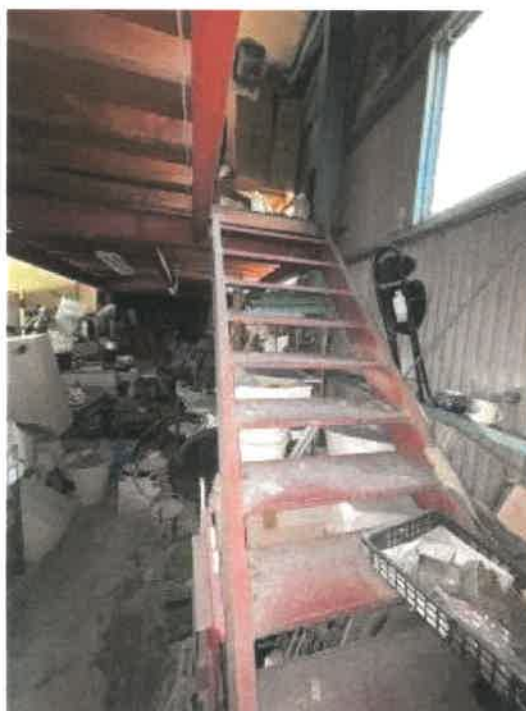
物件 3 附属建物 1 階の階段の状況
