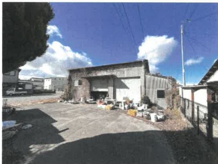
物件3 附属建物の状況
