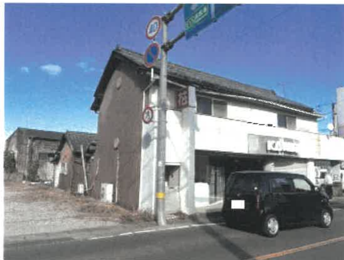
本件物件の南東側の状況
