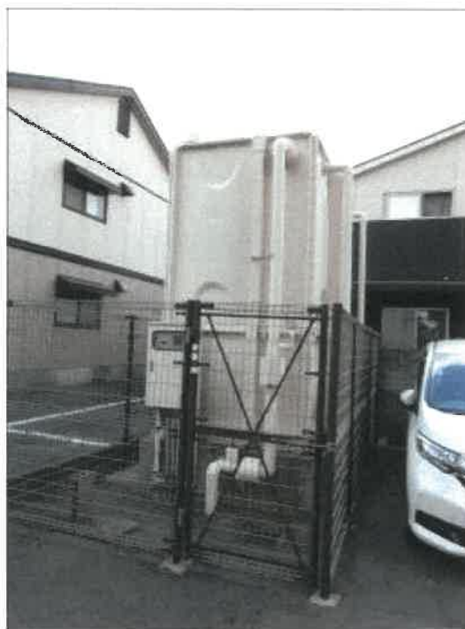
受命物件の存在するマンション北西側の受水槽の状況
