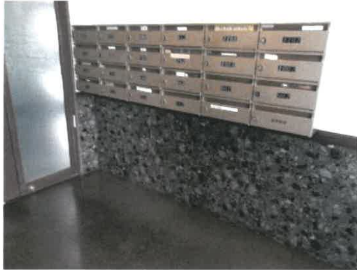
エントランスのメールコーナーの状況
