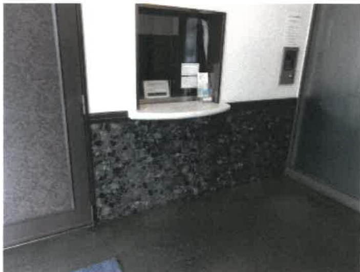
エントランスの管理人室窓口の状況
