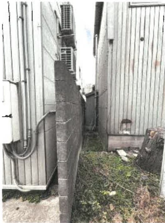
物件1 南側の状況
