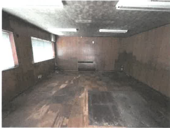
物件3 2階南側事務室の状況
