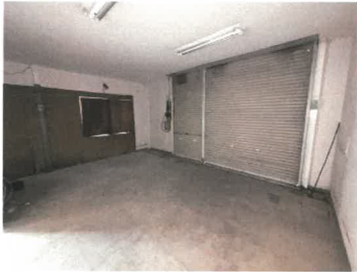
物件3 1階北西側倉庫の状況
