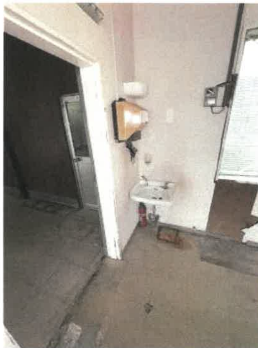
物件3 1階作業場南東側手洗場の状況
