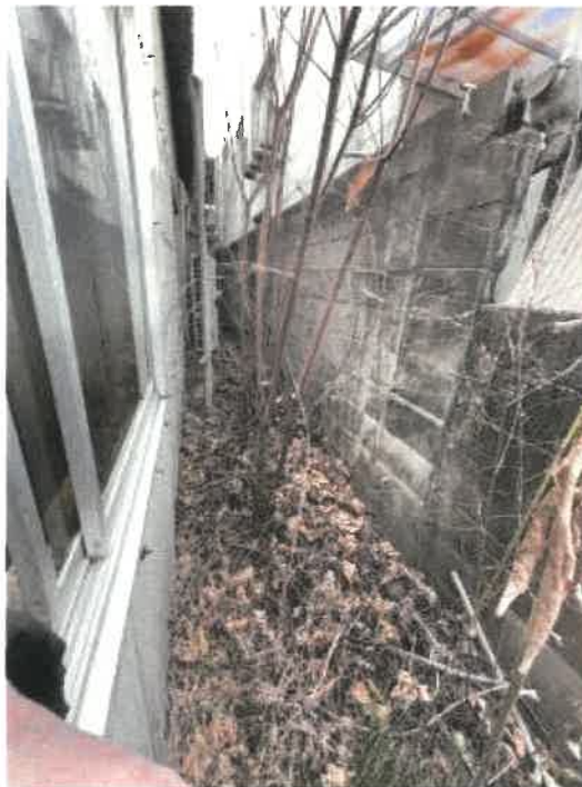
物件 2 南側の状況
