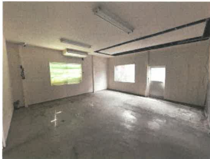
物件3 1階南西側倉庫の状況
