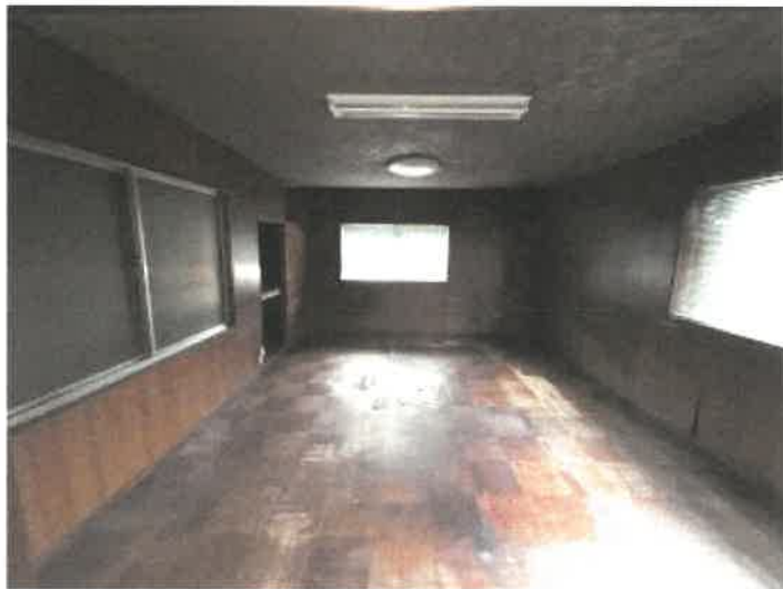
物件3 2階北側事務室の状況
