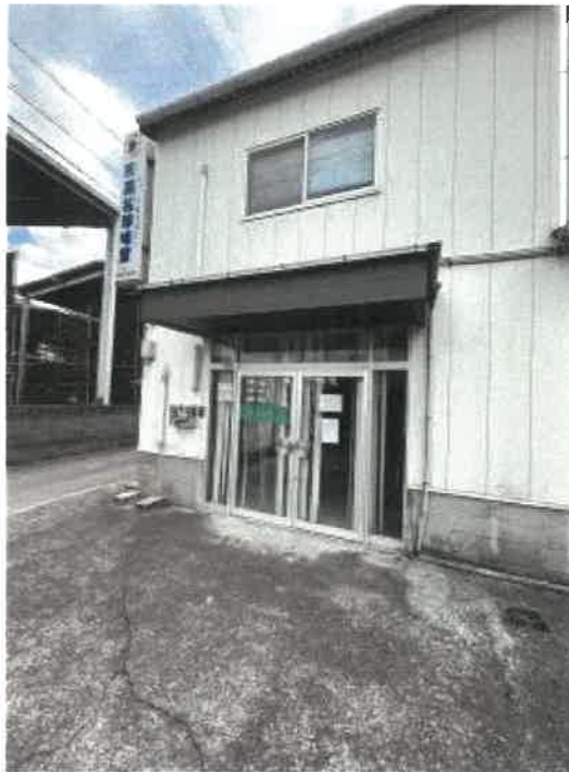
物件3 玄関付近の状況
