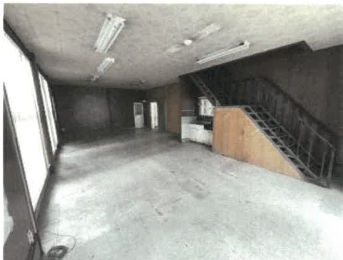
物件3 1階東側事務室の状況
