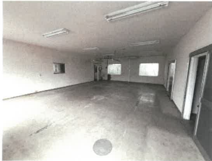
物件3 1階作業場の状況
