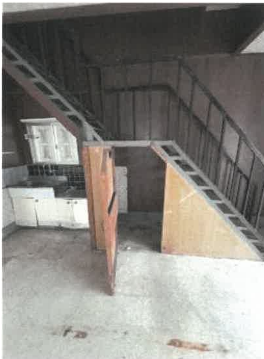
物件3 1階東側事務室階段下の状況
