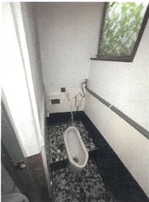
物件3 1階事務室南西側トイレの状況
