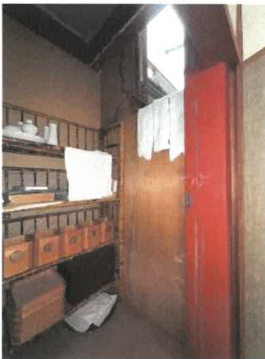
物件 2 4階西側和室奥の扉内の状況
