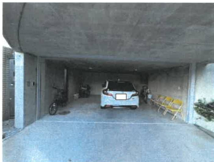
物件2 1階車庫の状況
