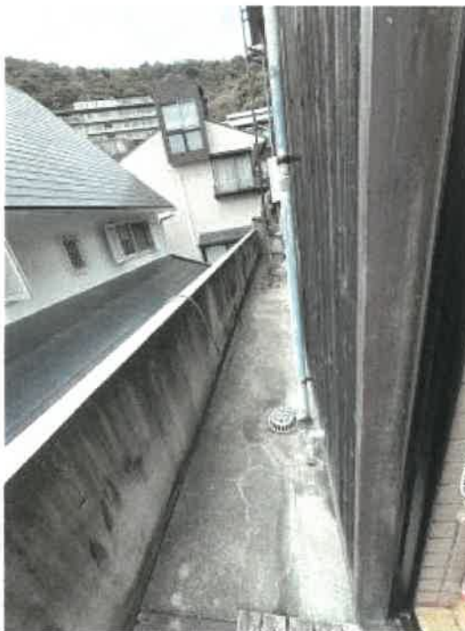
物件2 3階バルコニーの状況
