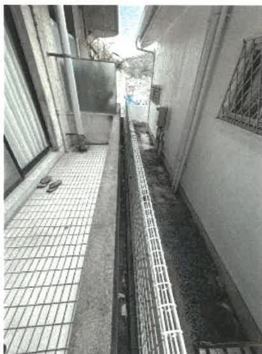
物件2 2階バルコニー付近の状況 (南側隣地との境界付近)
