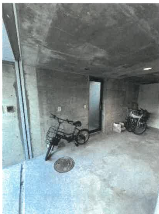
物件2 1階車庫内東側の状況
