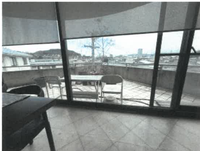
物件2 3階リビング北東側バルコニーの状況
