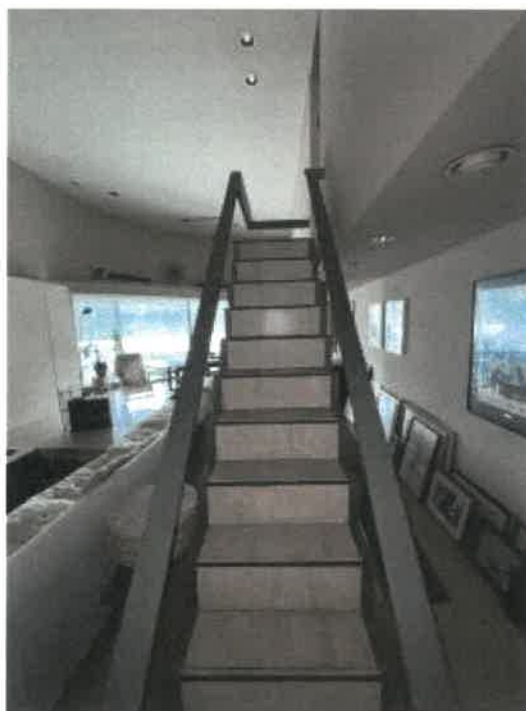
物件2 4階への階段の状況
