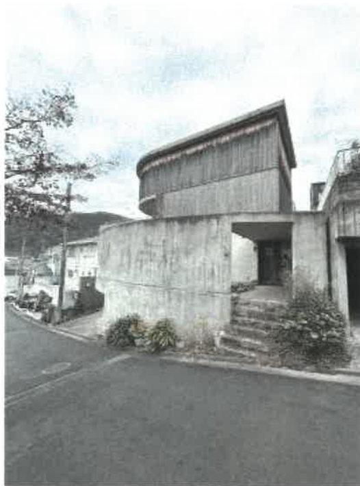
本件物件の北東側の状況
