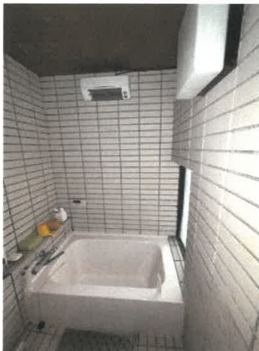
物件2 2階浴室の状況
