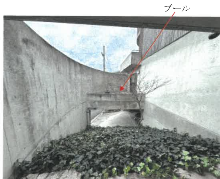
物件2 2階玄関ポーチ東側の状況
