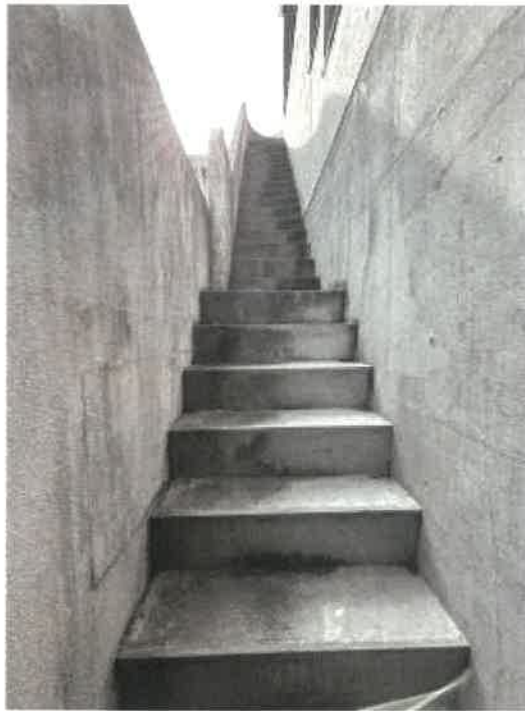
物件2 1階車庫東側扉外の外階段の状況
