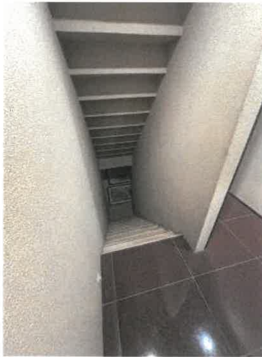
物件 2 1 階への階段の状況
