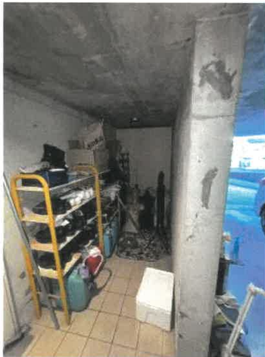
物件 2 1 階車庫西側の物置の状況
