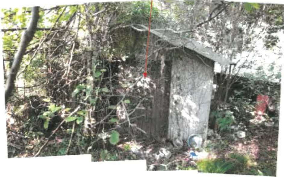
物件 2 1 未登記附属建物の状況
