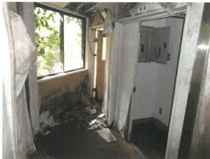
物件2 1 建物の浴室棟2階風呂場出入口付近の状況
