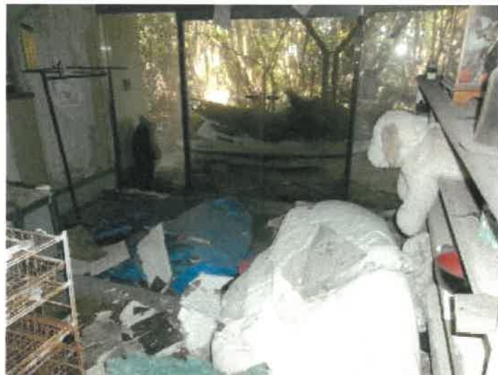
物件2 1建物ホテル棟1階（但し、建物間取図上は2階）の正面玄関内側の状況
