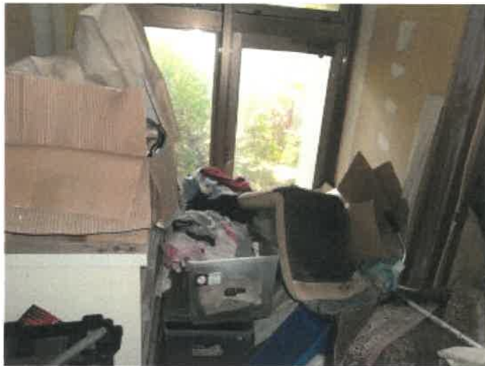
物件21建物ホテル棟1階（但し、建物間取図上は2階）南側の南端出入口付近の状況
