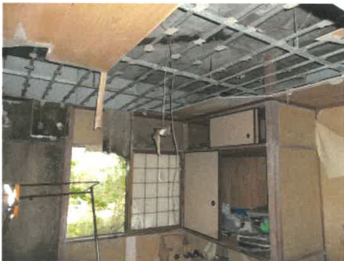
物件2 1建物ホテル棟1階（但し、建物間取図上は2階）南側東面南端和室の状況
