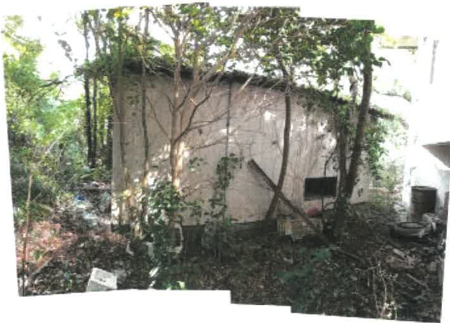
物件 2 1 未登記附属建物の状況
