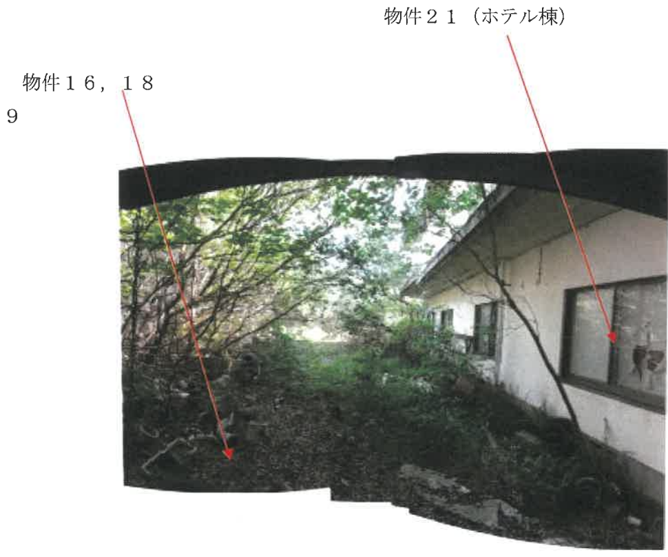
物件 21 (ホテル棟) 東側の状況
