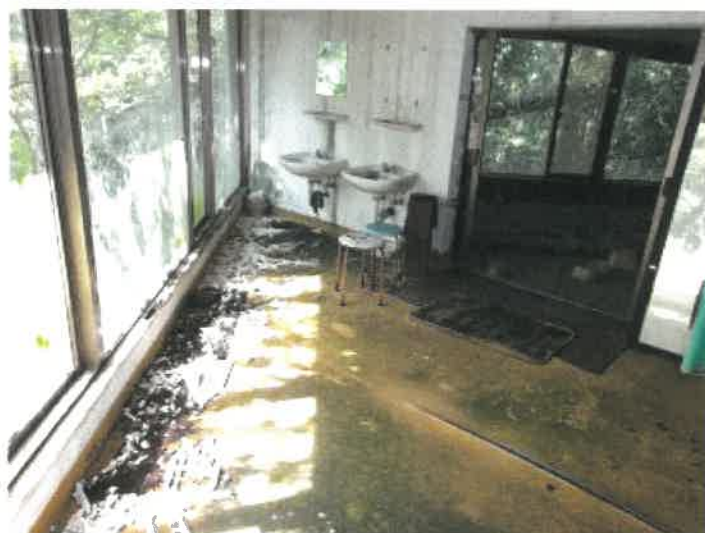
物件 2 1 建物の浴室棟 2 階北西側風呂場の更衣室から浴室出入口付近の状況
