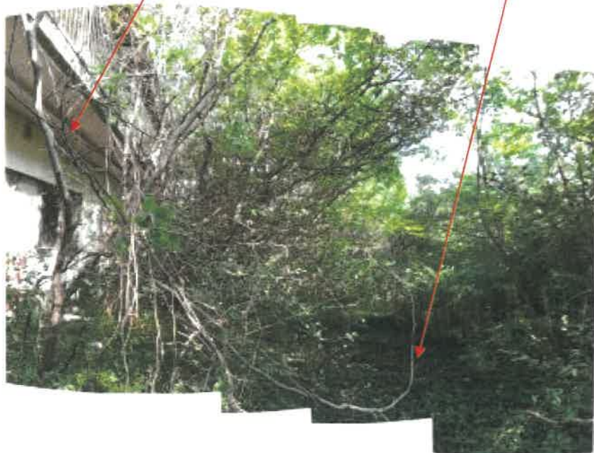
物件21 (ホテル棟) 西側の状況
