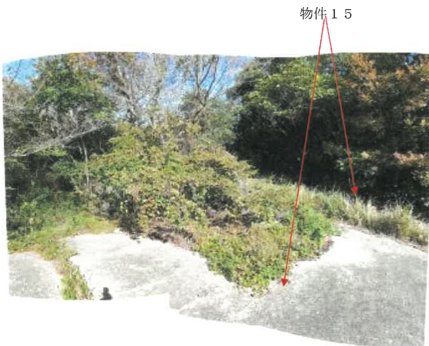
県道からホテルへの舗装通路付近の状況
