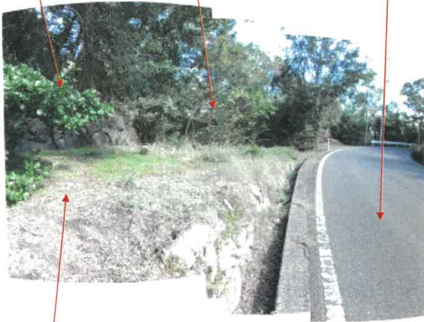
物件 1 5 土地南東側境界付近の状況
