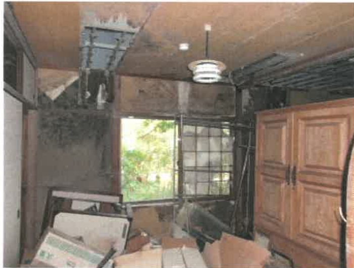
物件2 1建物ホテル棟1階（但し、建物間取図上は2階）南側東面南から2つ目の和室の状況
