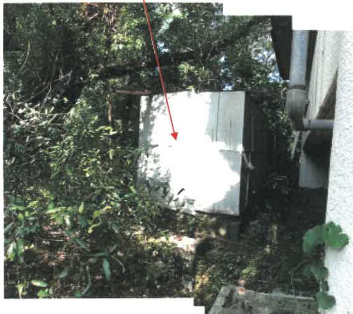
物件 2 1 (風呂場棟) 北西側の貯水槽の状況
