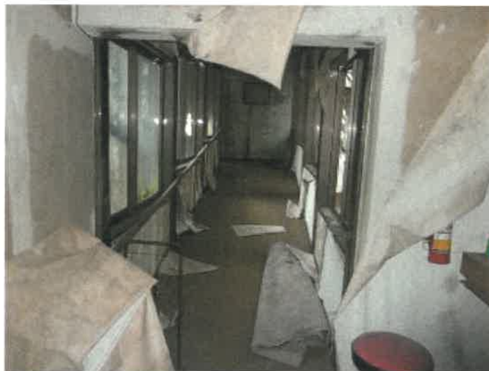
物件21建物ホテル棟1階（但し、建物間取図上は2階）北西側の中央付近北東側浴室棟 2階への廊下の状況
