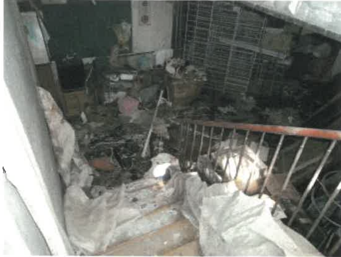
物件 2 1 建物階段の状況
