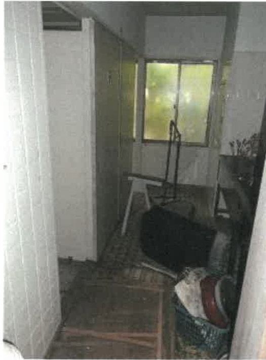
物件21建物ホテル棟1階（但し、建物間取図上は2階）南側トイレの状況
