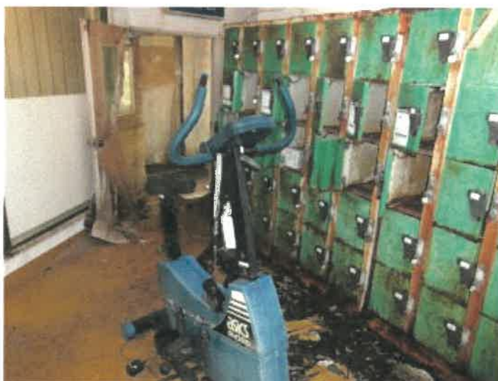
物件2 1 建物の浴室棟2階南東側風呂場の更衣室の状況
