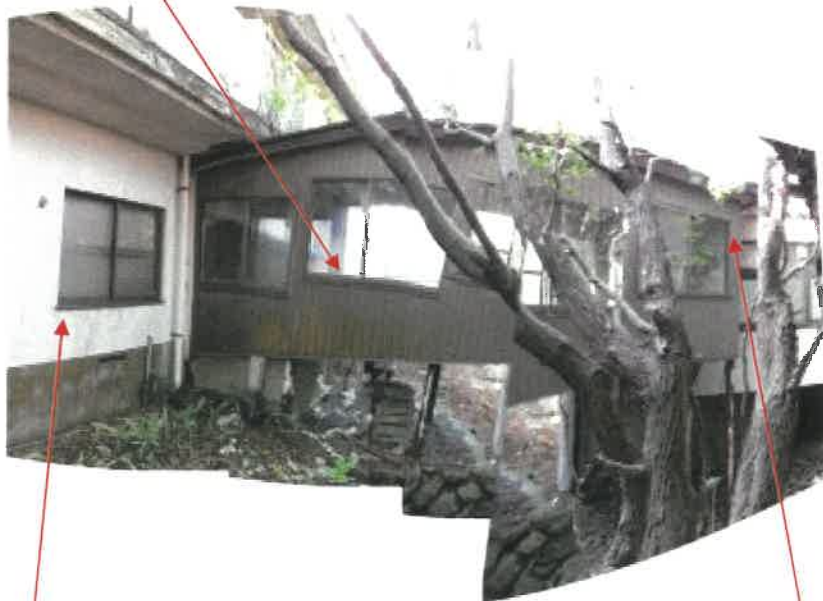
物件 2 1 のホテル棟から風呂場棟への廊下の状況
