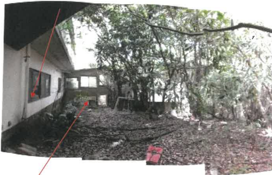
物件 2 1 建物 (ホテル棟) の北東側の状況
