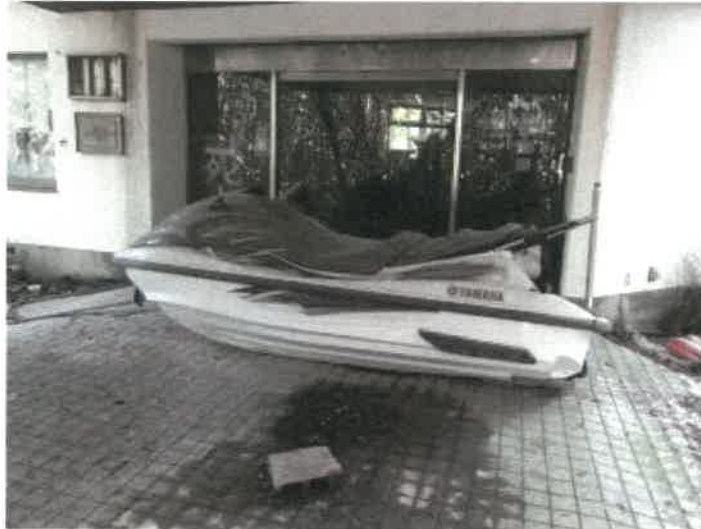
物件2 1建物ホテル棟1階（但し、建物間取図上は2階）の正面玄関外側の状況
