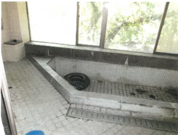
物件 2 1 建物の浴室棟 2 階北西側風呂場の浴室の状況
