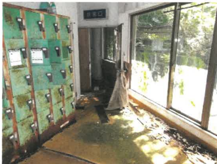
物件 2 1 建物の浴室棟 2 階北西側風呂場の更衣室の状況
