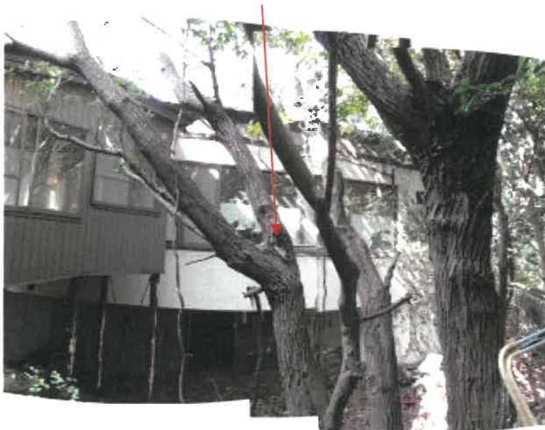
物件 2 1 (風呂場棟) 南側の状況
