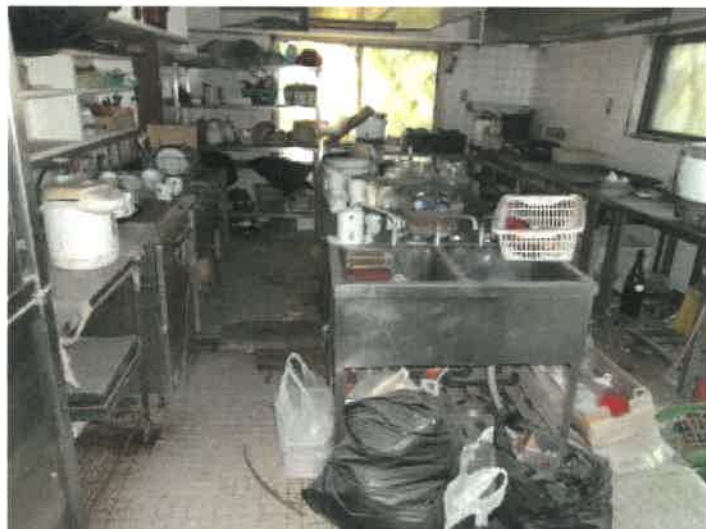
物件2 1建物ホテル棟1階（但し、建物間取図上は2階）北西側の北端厨房の状況
