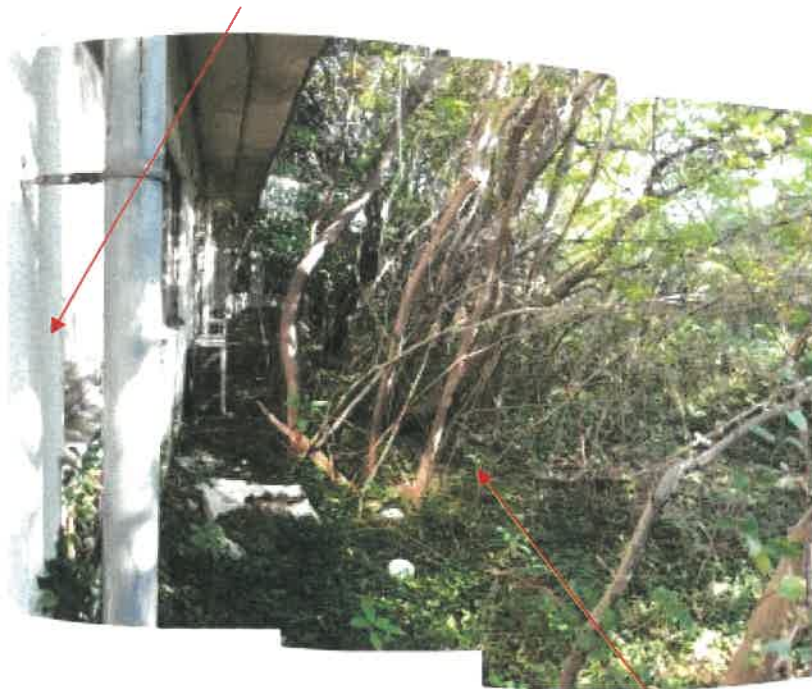
物件 2 1 建物 (ホテル棟) 南西側の状況
