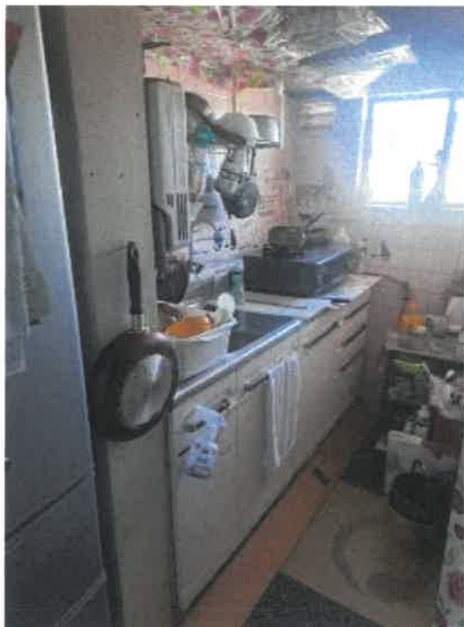
物件 7 建物の 1 階台所の状況
