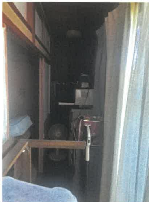
物件 7 建物の 1 階西側和室北側の縁側の状況
