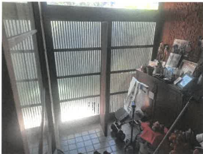
物件7建物の1階玄関付近の状況
