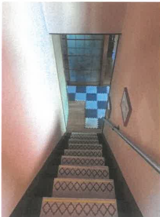
物件7建物の階段の状況
