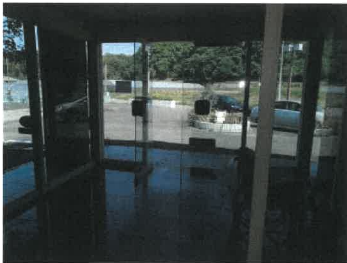
物件 9 建物部分 1 階玄関内の状況
