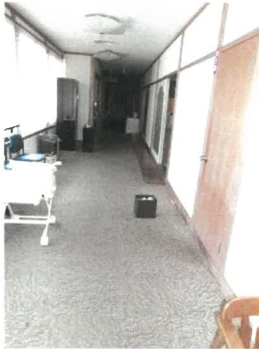
物件 8 建物部分 2 階東西廊下の状況
