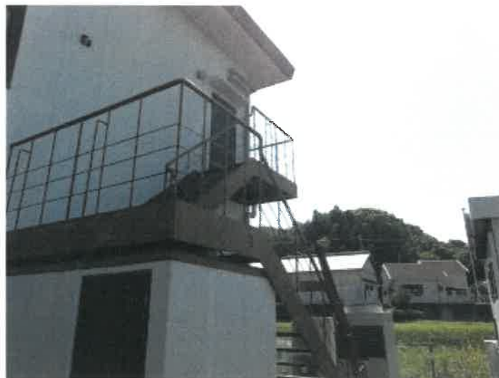
物件 9 建物部分北東側非常階段下の状況
