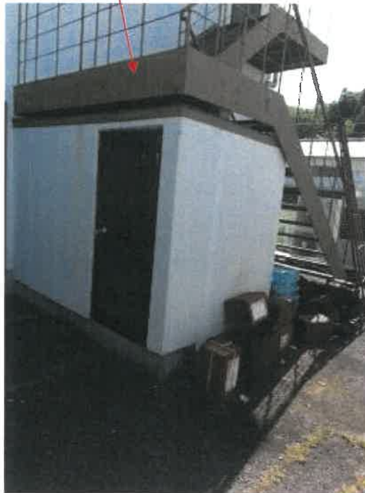
物件 9 建物部分北東側非常階段下の倉庫の状況
