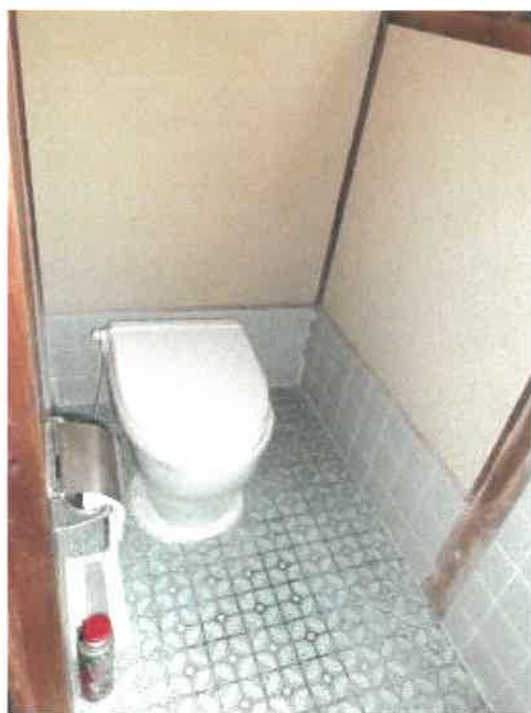
物件8建物部分の内の居宅部分1階南東側南和室南側広縁東端のトイレの状況
