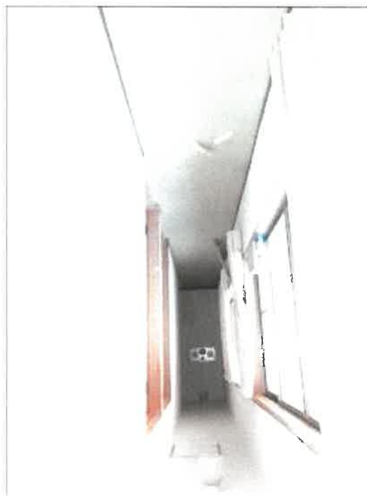
物件 8 建物部分の内の居宅部分 2 階廊下の状況
