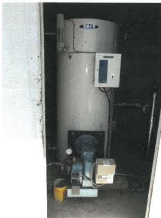
西側機械室東端のボイラー室の状況
