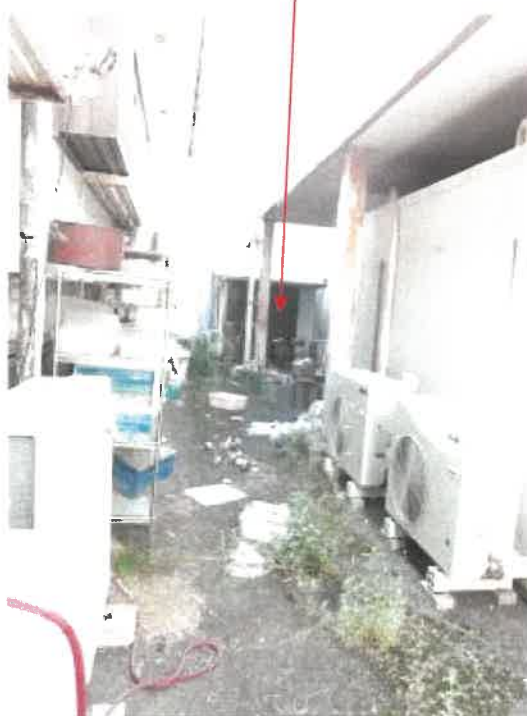
物件8建物部分と物件9建物部分の間の空間の状況
