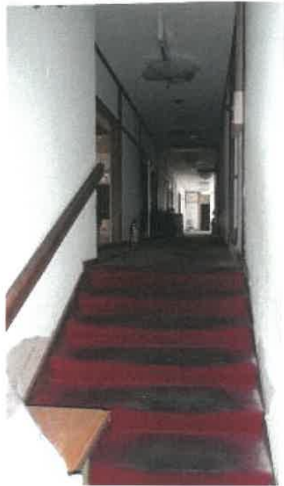
物件 8 建物部分 1 階西端付近 2 階への階段の状況
