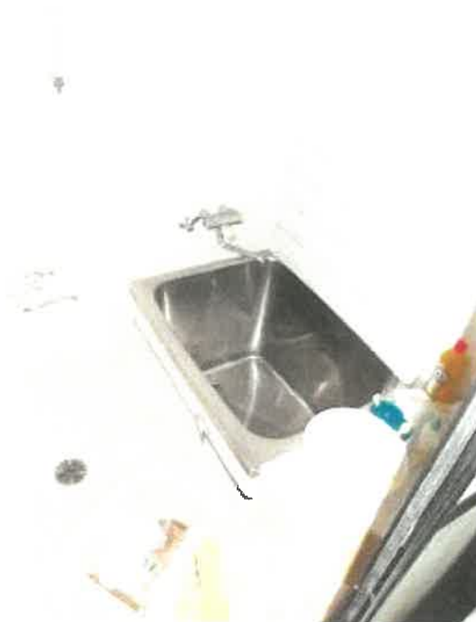
物件 9 建物部分 1 階事務所北側洋室の浴室の状況
