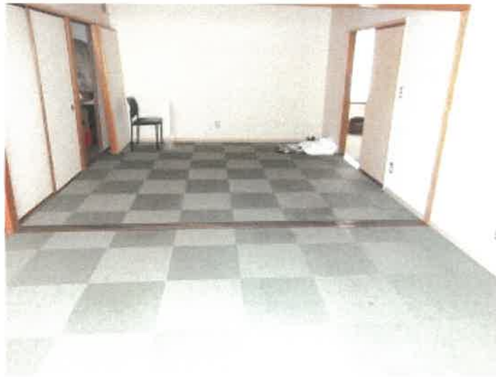
物件 8 建物部分 2 階東端洋室の状況
