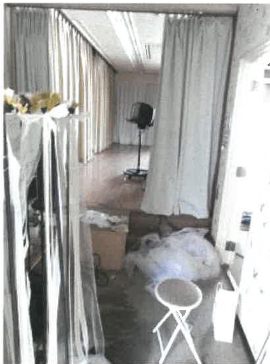
物件 9 建物部分の 2 階西側宴会場のステージ南側前室の状況
