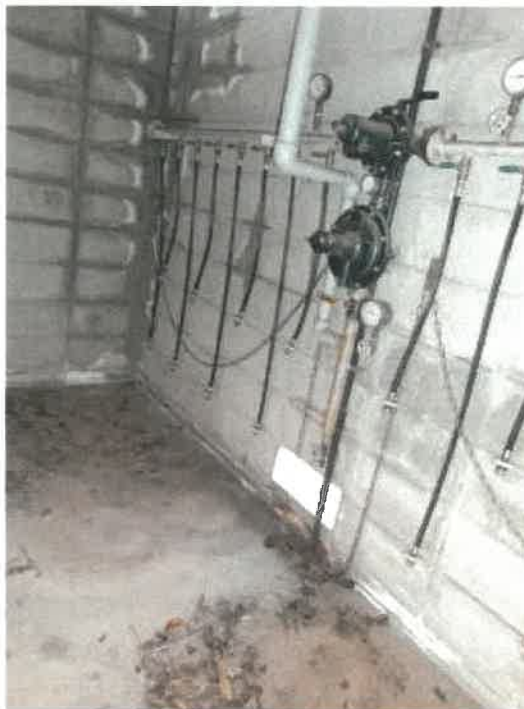
西側機械室中のプロパン庫の状況
