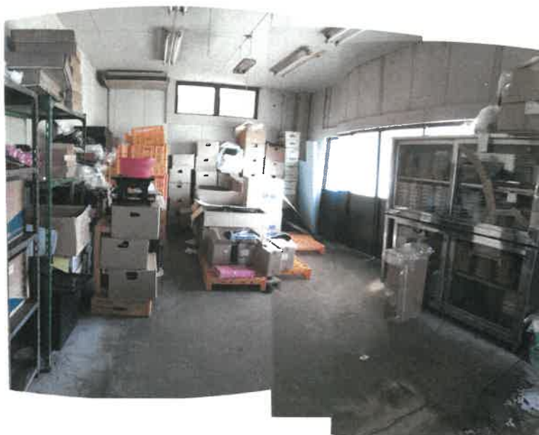
物件 9 建物部分 1 階厨房南西角付近の状況
