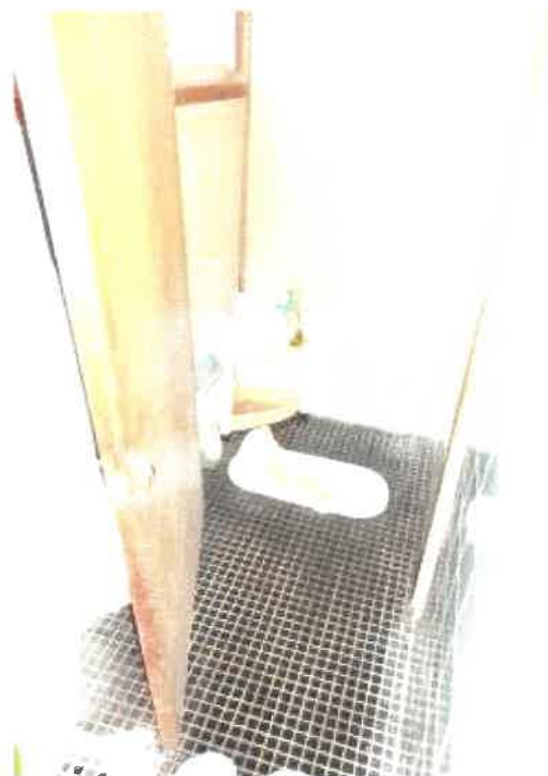
物件8建物部分の内の居宅部分1階北東側和室南側のトイレの状況
