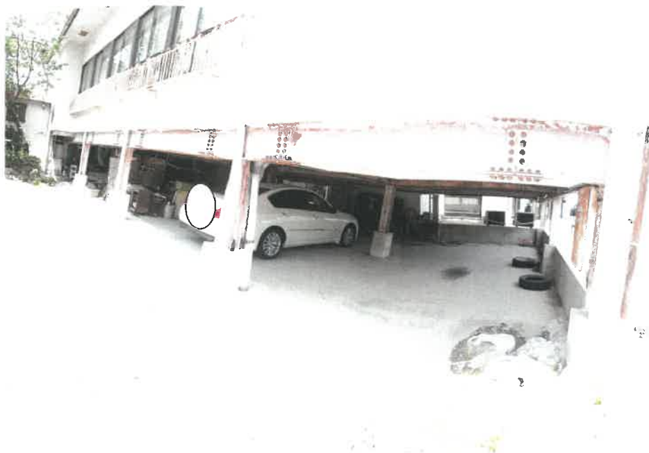
物件 8 建物部分 1 階ピロティ東側付近の状況
