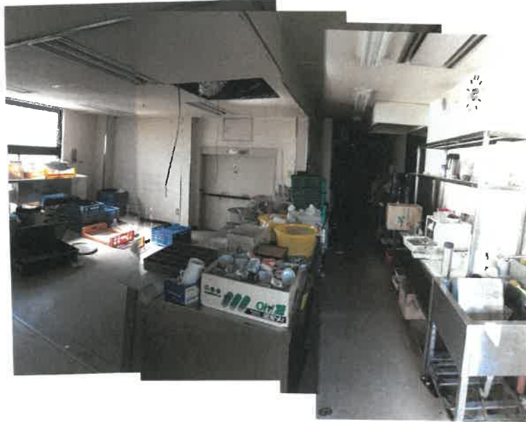
物件 9 建物部分の 2 階西側配膳室の状況
