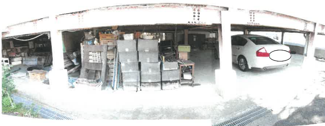
物件 8 建物部分 1 階ピロティ中央付近の状況
