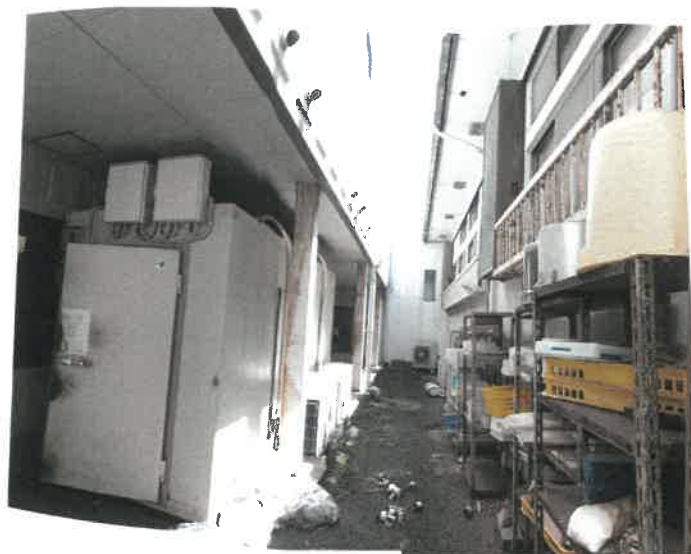
物件8建物部分と物件9建物部分の間の空間の状況
