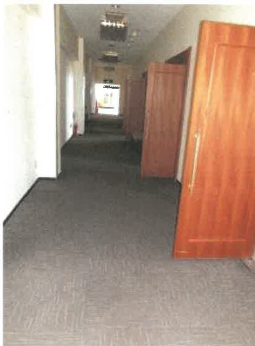
物件9建物部分の2階東西廊下の状況
