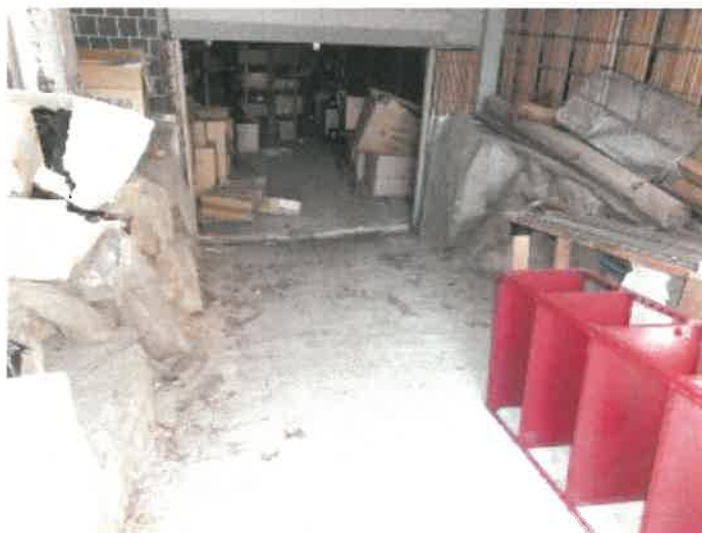
物件 8 建物部分 1 階南側トイレ西側の倉庫への出入口付近の状況
