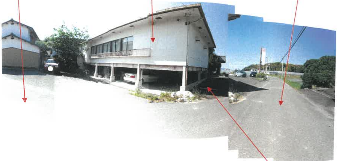
物件4土地南側及び東側境界付近の状況
