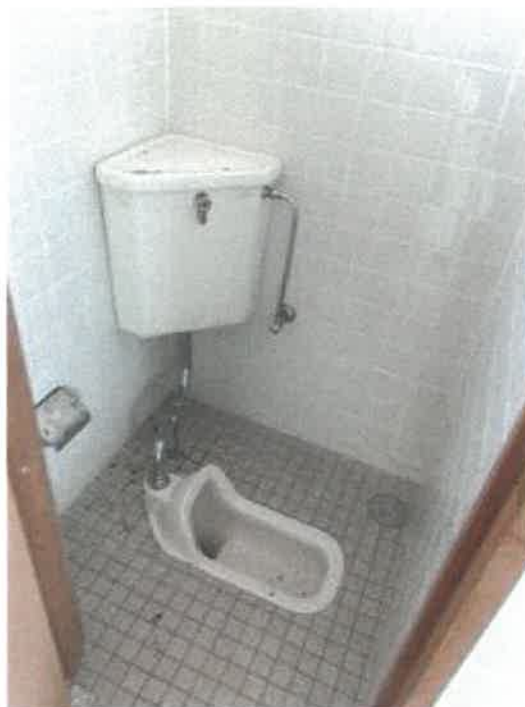
物件 9 建物部分の 2 階南側男子トイレの状況
