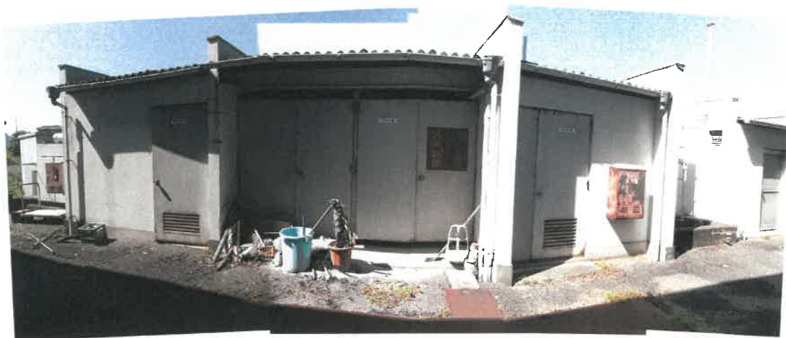
西側機械室の状況
