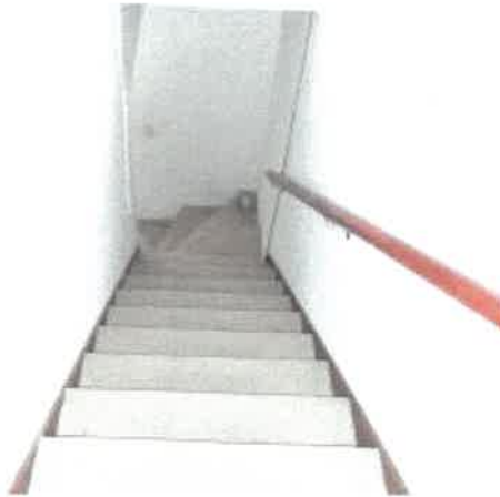
物件 8 建物部分の内の居宅部分階段の状況
