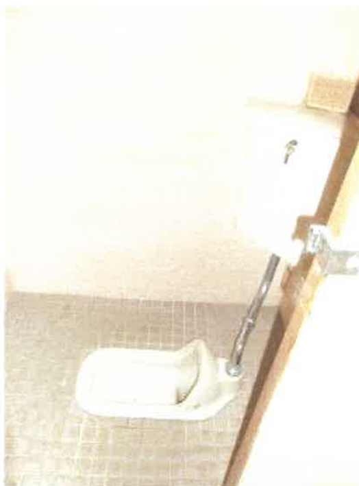
物件 8 建物部分 1 階女子トイレの状況
