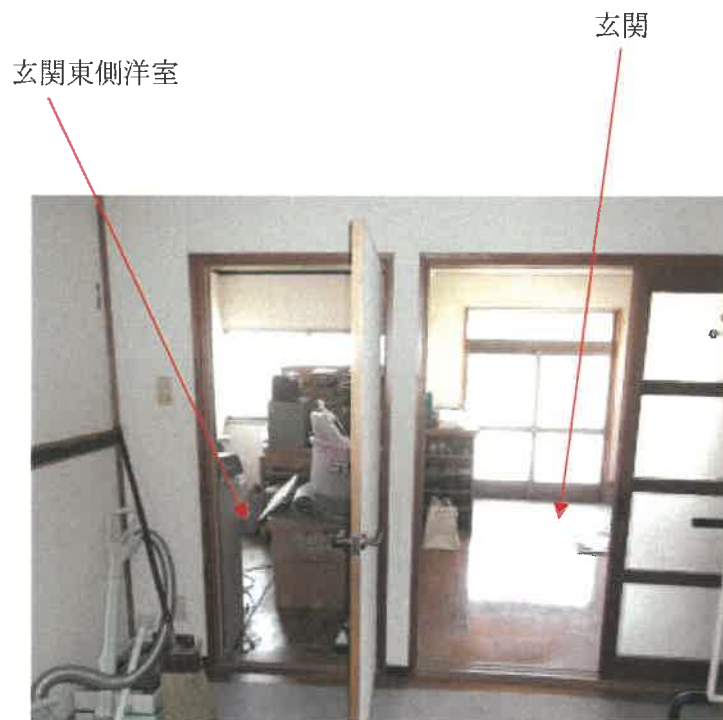
物件 8 建物部分の内の居宅部分 1 階玄関及び東側洋室の状況
