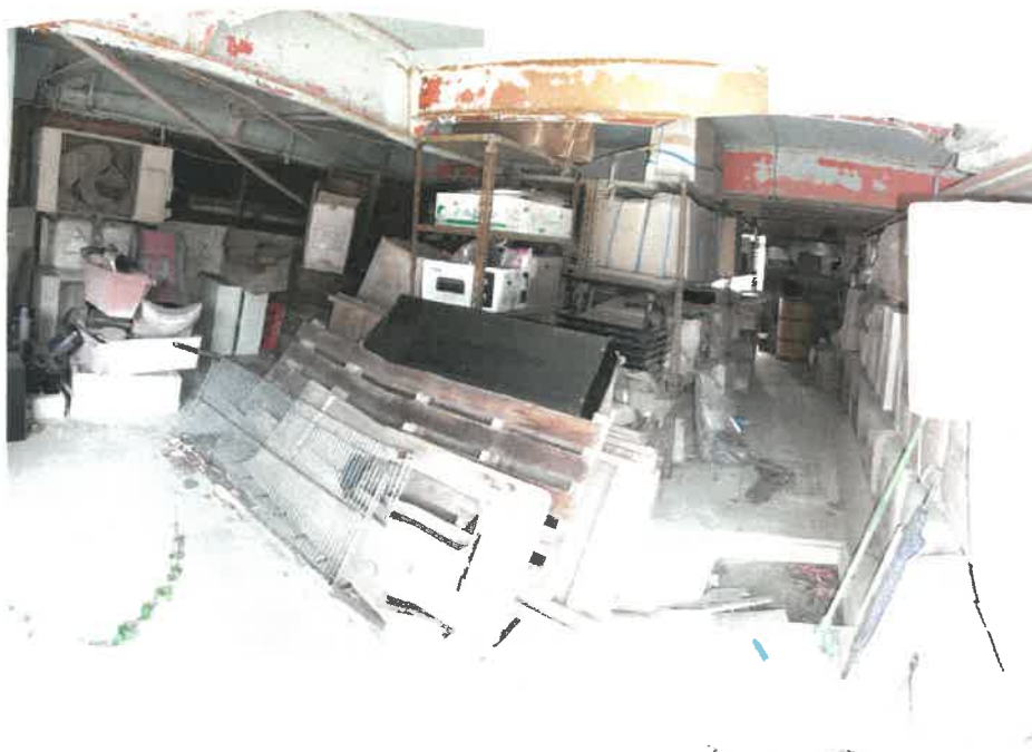
物件8建物部分1階ピロティ中央付近の状況
