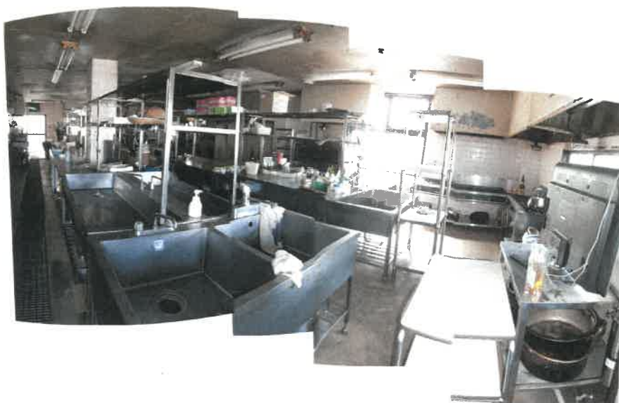
物件9建物部分1階厨房の状況
