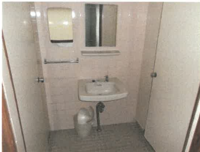
物件 8 建物部分 1 階女子トイレの状況
