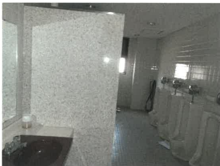
物件9建物部分1階の北側男子トイレの状況
