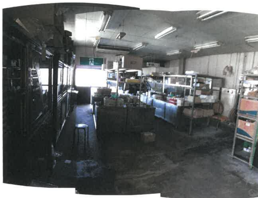
物件9建物部分1階厨房の状況
