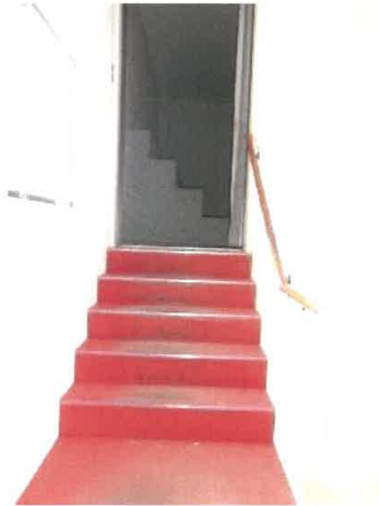
物件 9 建物部分の 2 階南西側スタジオと物件 8 建物部分 2 階の式場との間の階段の状況
