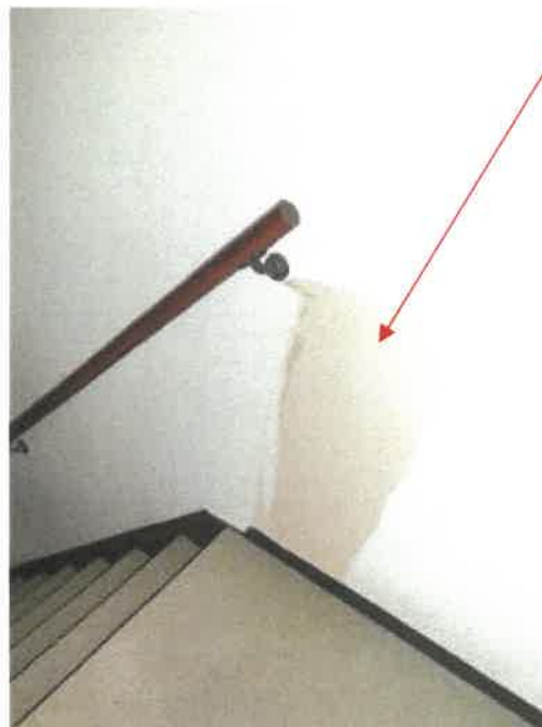
物件8建物部分の内の居宅部分2階階段下り口付近の状況
