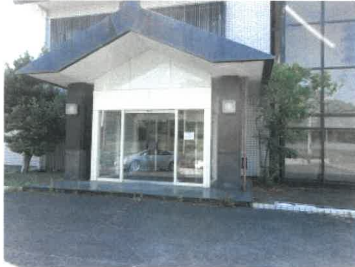
物件 9 建物部分 1 階玄関付近の状況
