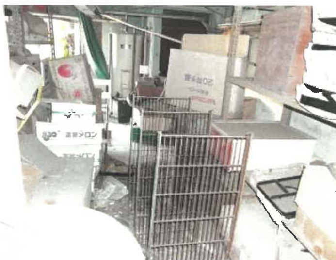
物件8建物部分1階ピロティ西端付近の状況
