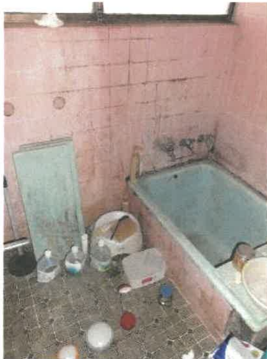
物件2建物浴室の状況
