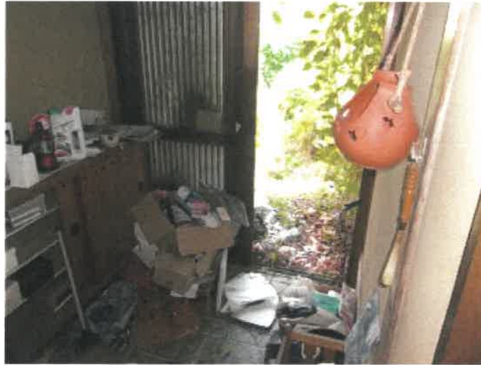
物件 2 建物玄関内の状況
