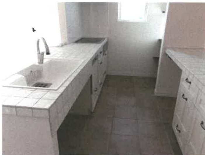
物件3建物の1階キッチンの状況
