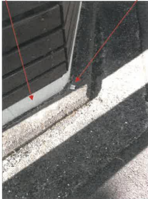
物件2 土地北東角付近の状況
