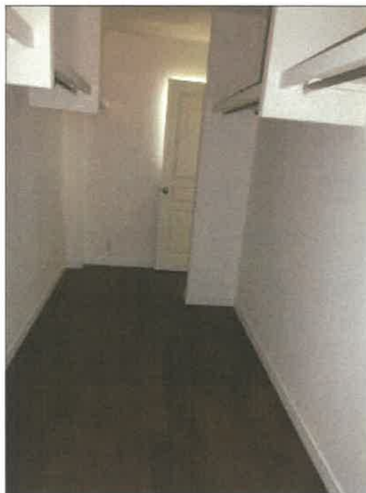
物件3建物の2階西側納戸の状況
