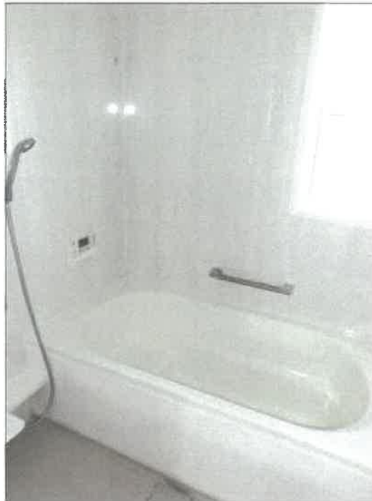
物件3建物の1階浴室の状況
