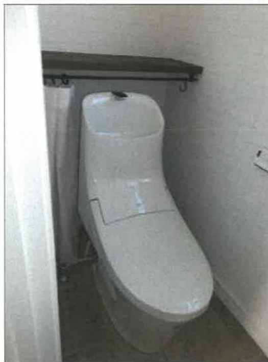
物件3建物の1階トイレの状況
