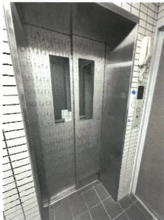
エレベータ付近の状況
