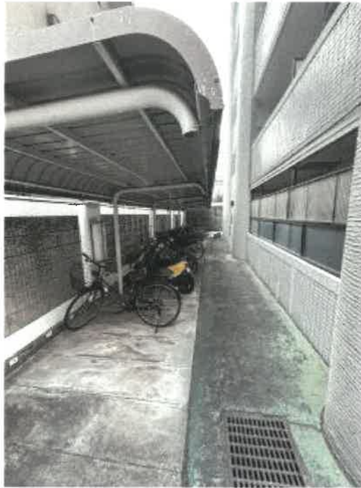
東側駐輪場の状況
