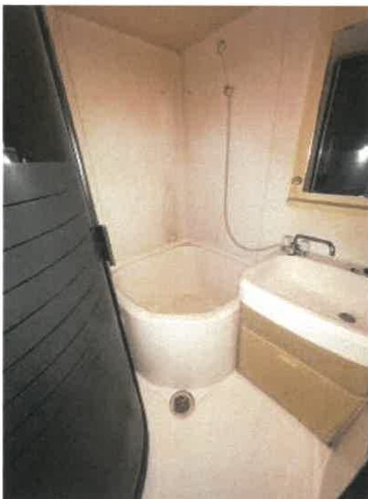
ユニットバスの状況
