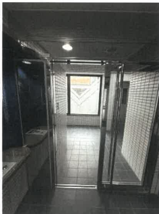
玄関ホールの状況
