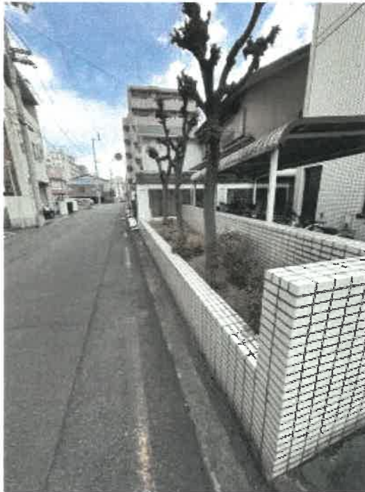
北東側植込みの状況
