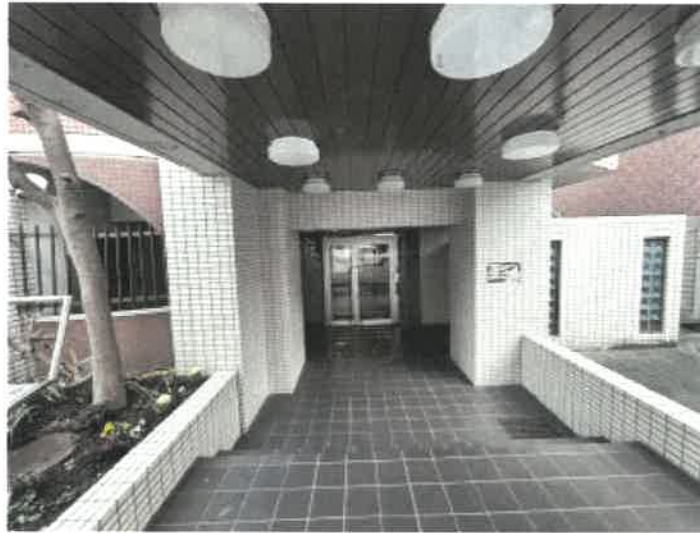
マンション入口付近の状況
