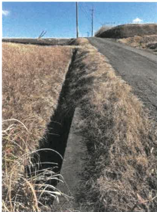
物件1東隣（515-1）前の水路の状況
