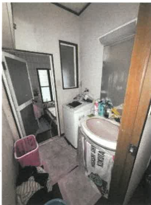
物件2 1階洗面所脱衣所の状況
