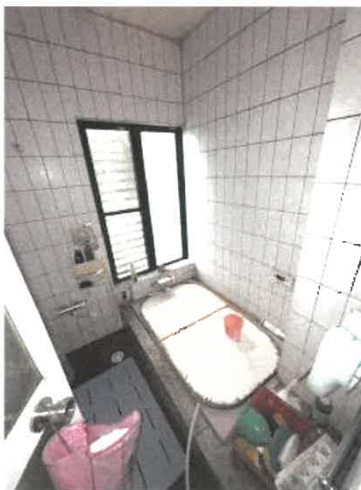
物件2 1階浴室の状況
