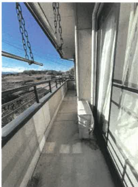
物件2 2階ベランダの状況
