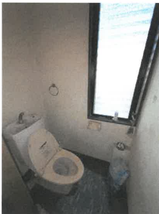
物件2 2階トイレの状況
