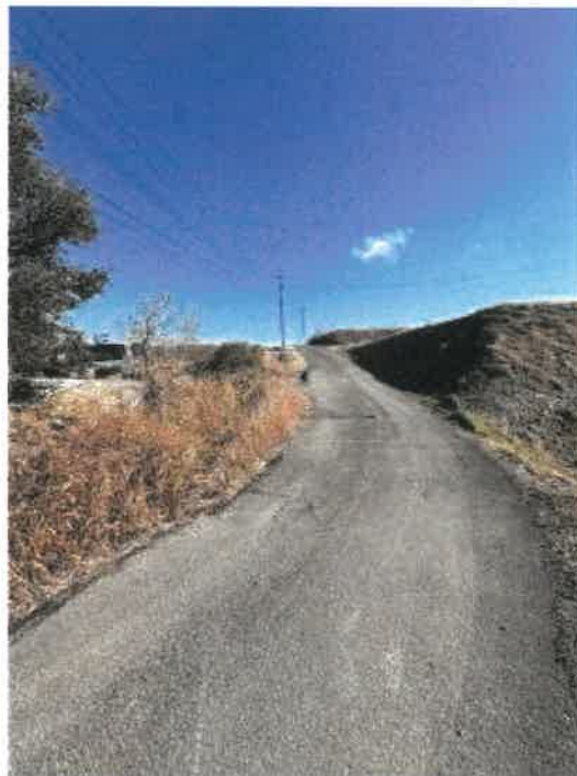
物件1 南側道路の状況
