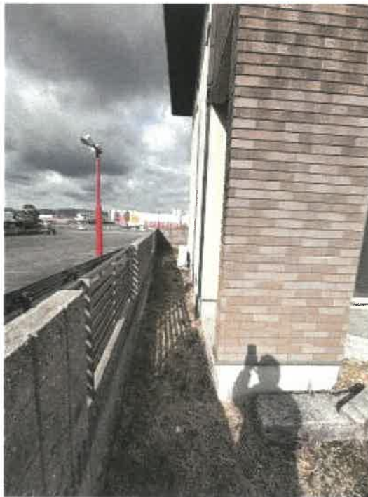
物件2 南西側の状況
