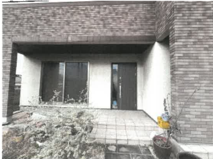
物件2 玄関付近の状況
