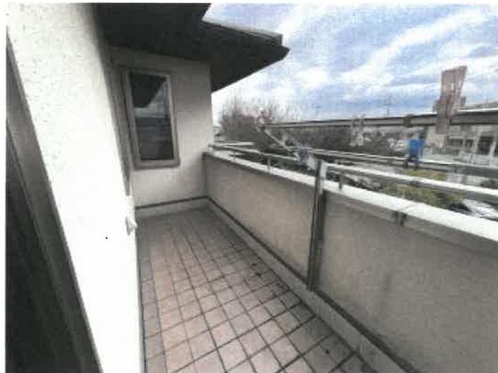
物件 2 2階南側バルコニーの状況
