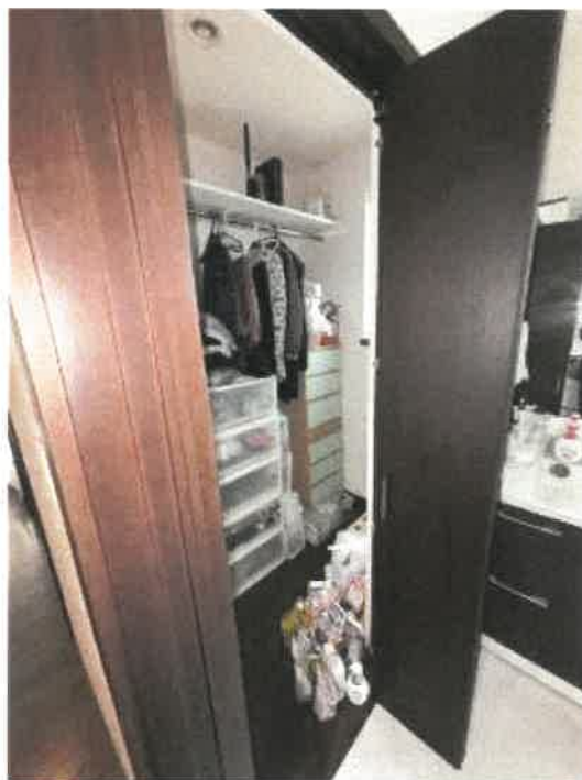
物件2 1階クローゼットの状況
