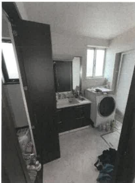
物件2 1階洗面脱衣所の状況
