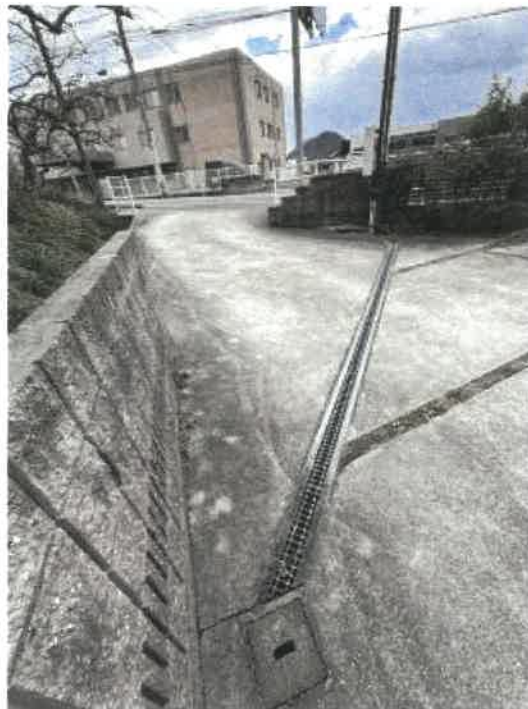
物件1 南東側排水路の状況
