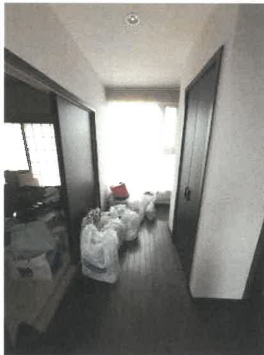
物件2 1階廊下の状況
