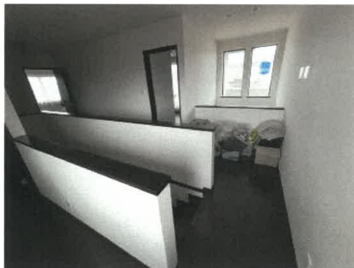
物件2 2階廊下の状況
