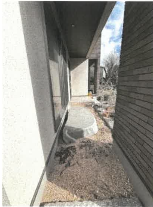
物件2 南側の状況
