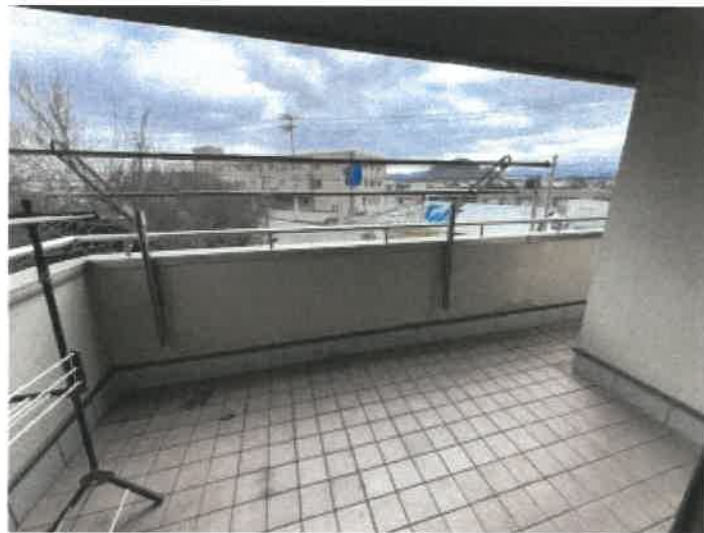
物件2 2階東側バルコニーの状況
