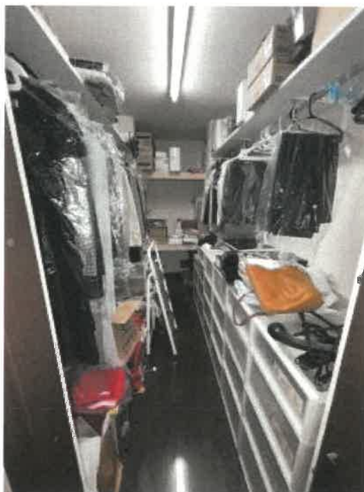
物件2 2階クローゼットの状況
