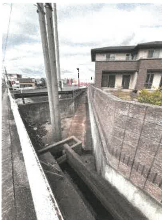
本件物件の南側の状況
