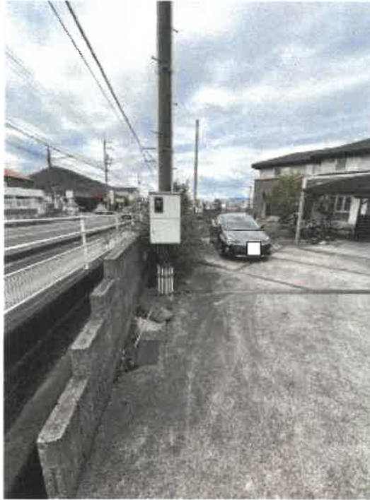
物件1 私設電柱の状況
