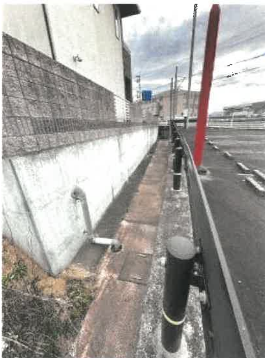
本件物件の南西側水路の状況
