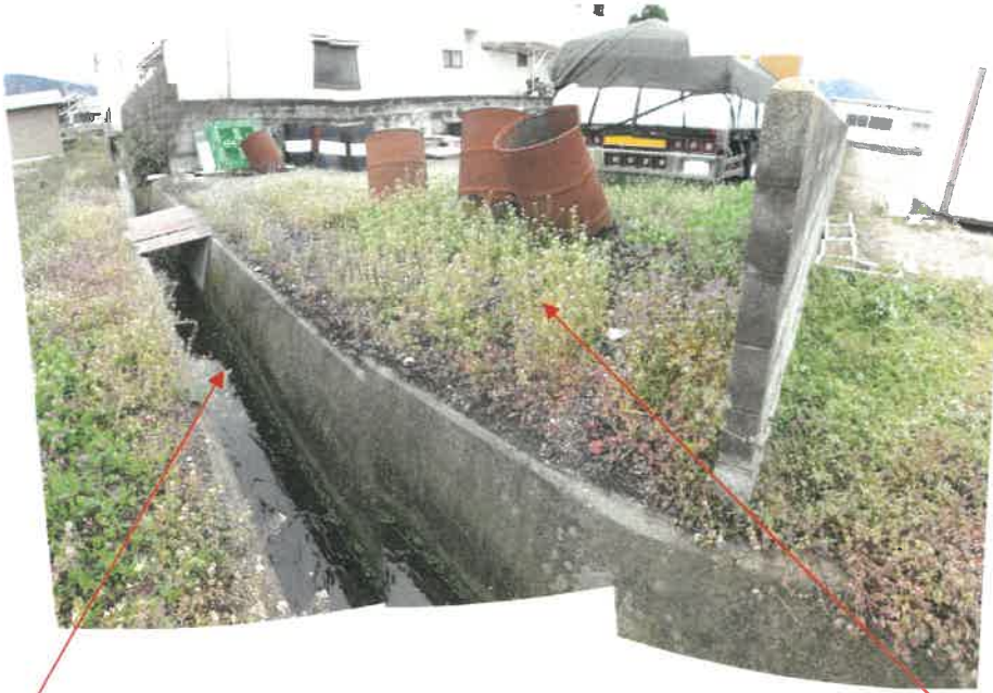
物件1 土地北東側及び北西側境界付近の状況
