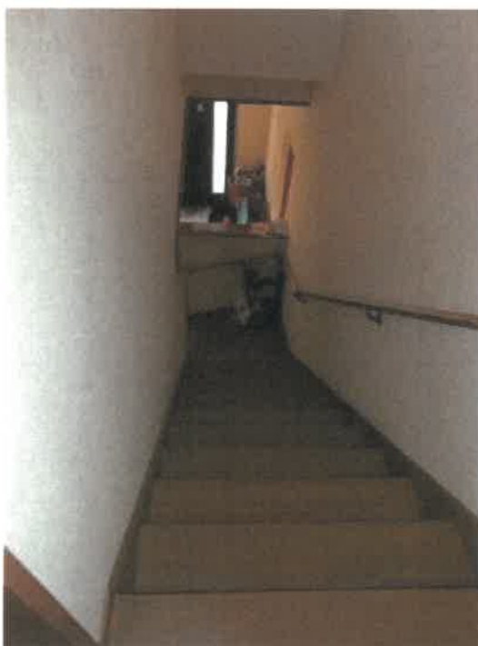
物件 1 建物階段の状況
