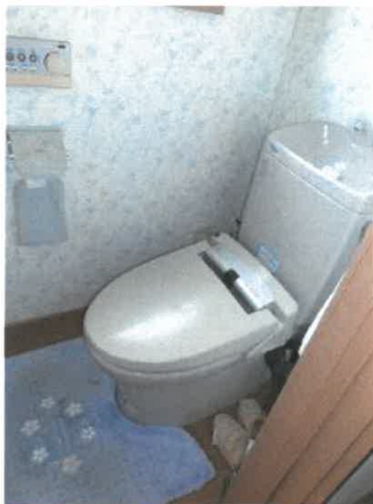
物件 1 建物 1 階北側ゾーントイレの状況
