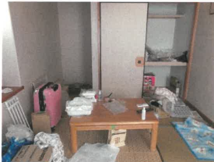
物件1建物1階北側ゾーン和室の状況
