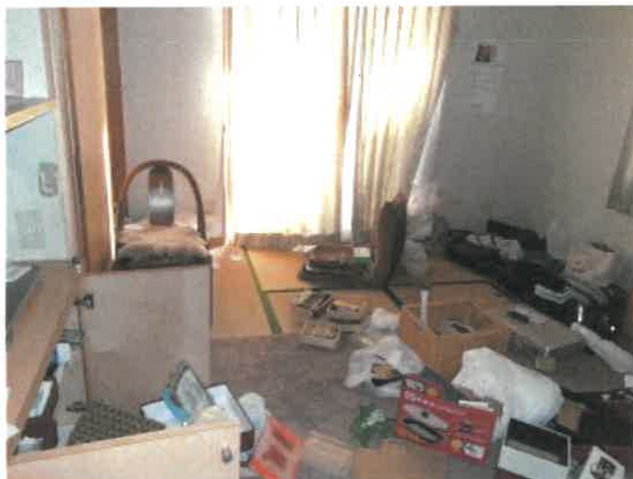
物件1建物1階南側ゾーン東和室の状況
