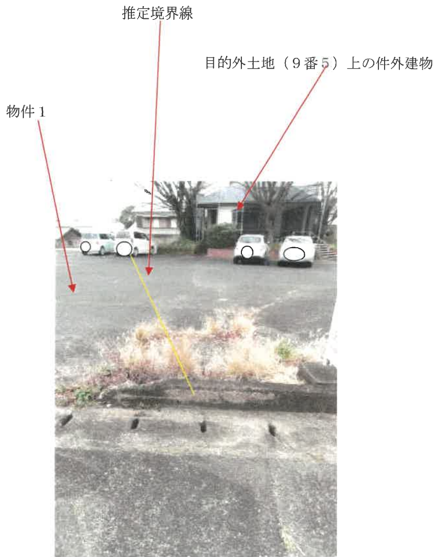
物件1 土地南東側境界付近の状況
