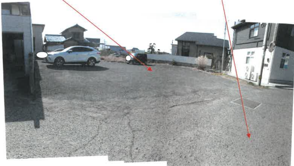
物件1, 2土地北側, 北西側及び東側境界付近の状況
