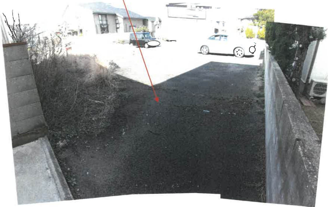
物件 1, 2 土地東側及び南側境界付近の状況
