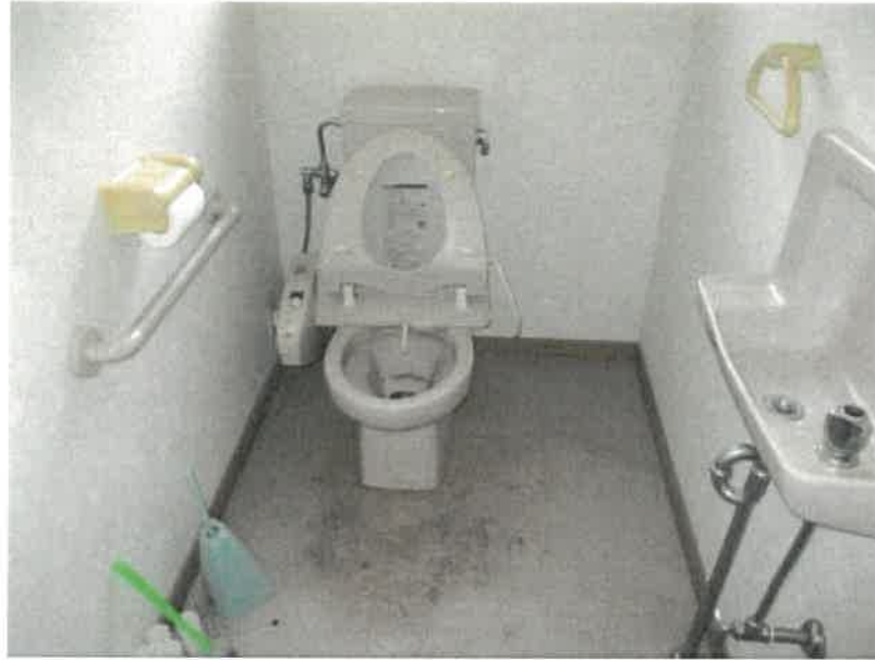
1 1 物件 4 建物の便所の状況
