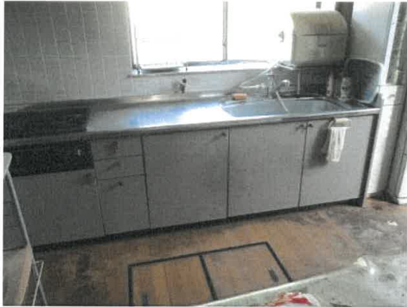
7 物件4建物の台所の状況
