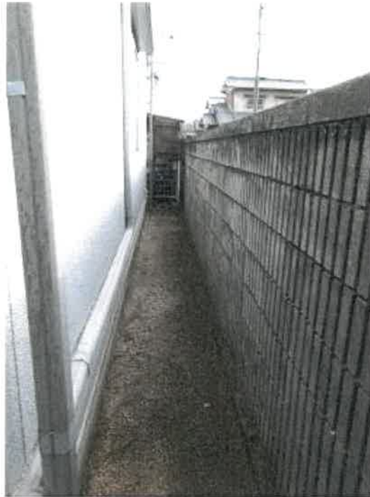
物件1 建物東側の状況
