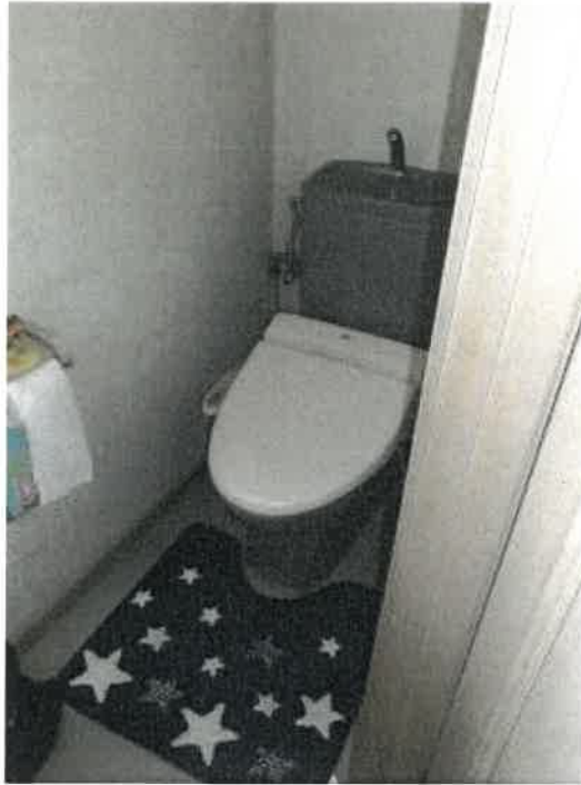
2階トイレの状況
