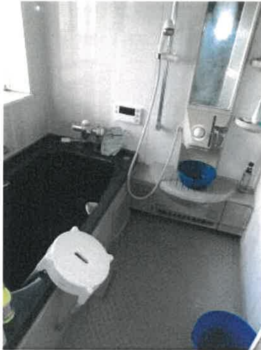
1階浴室の状況
