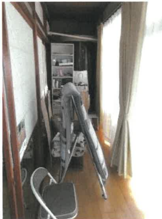
物件2建物DK南側和室南側廊下の状況
