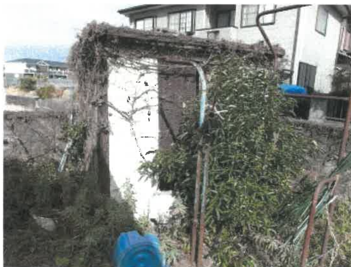
物件1土地北東角のスチール製物置（動産）の状況
