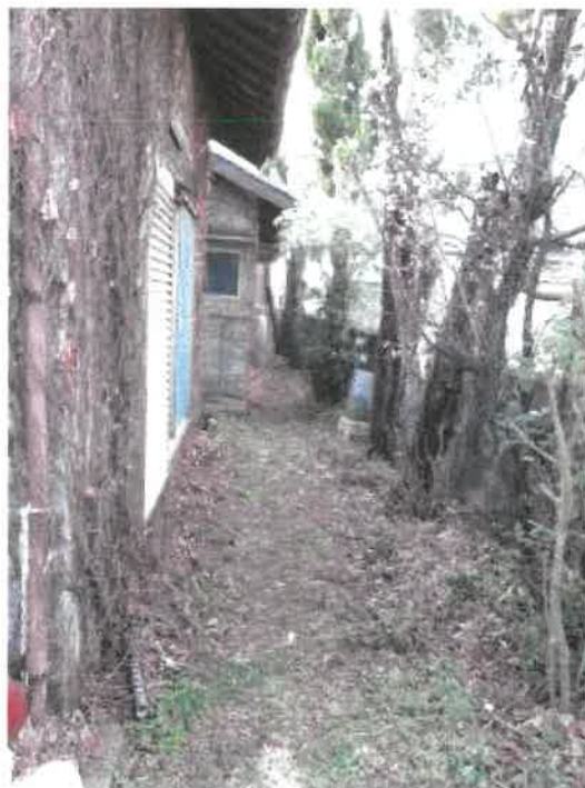
物件2建物北側の状況
