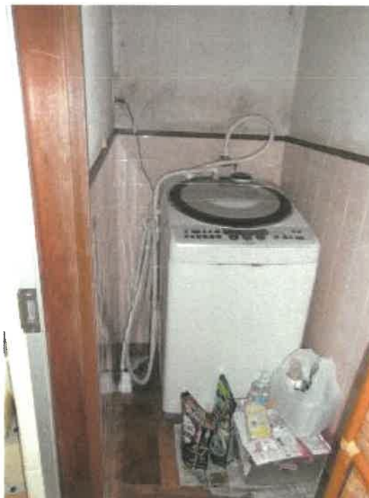
物件2建物脱衣所の状況
