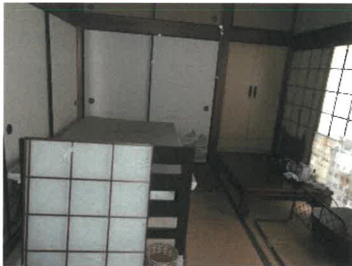
物件 2 建物西側 2 間北側和室の状況
