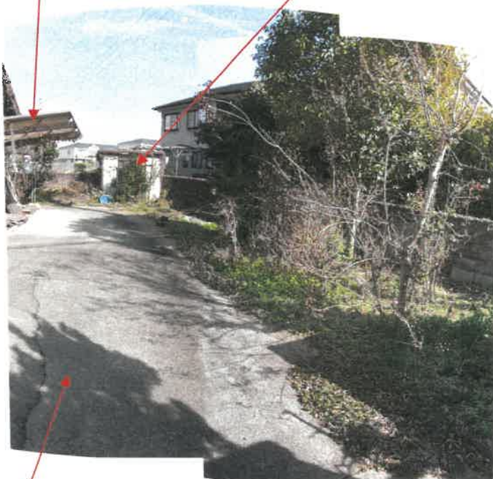
物件1 土地東側駐車場付近の状況
