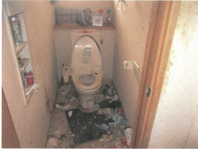
7 物件2建物の1階トイレの状況
