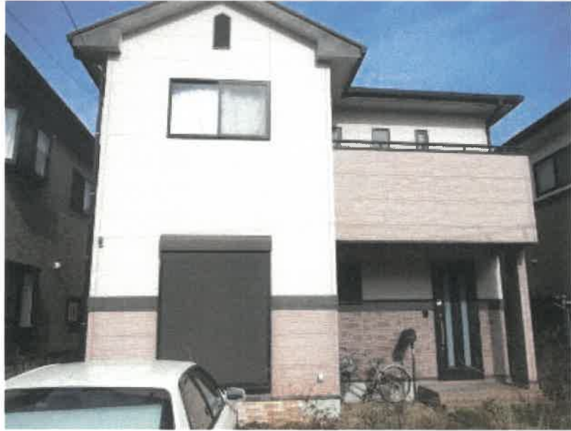
1 物件1土地と物件2建物の状況
