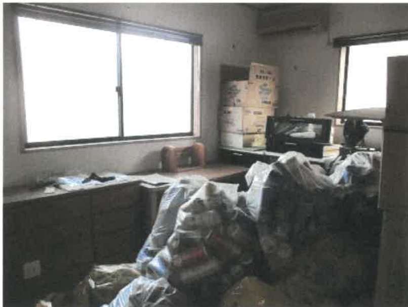
10 物件2建物の2階洋室2の状況
