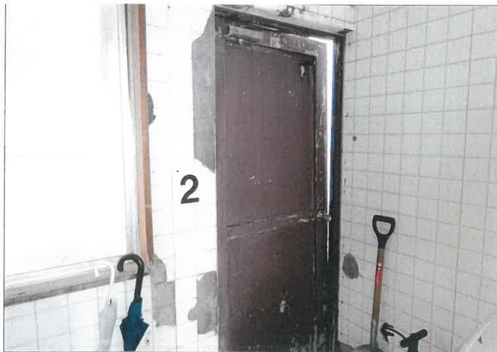
(5) 1階 駐車場南西端のドア
