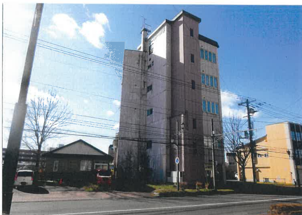
(2) 本建物の外観(北東側から撮影)
