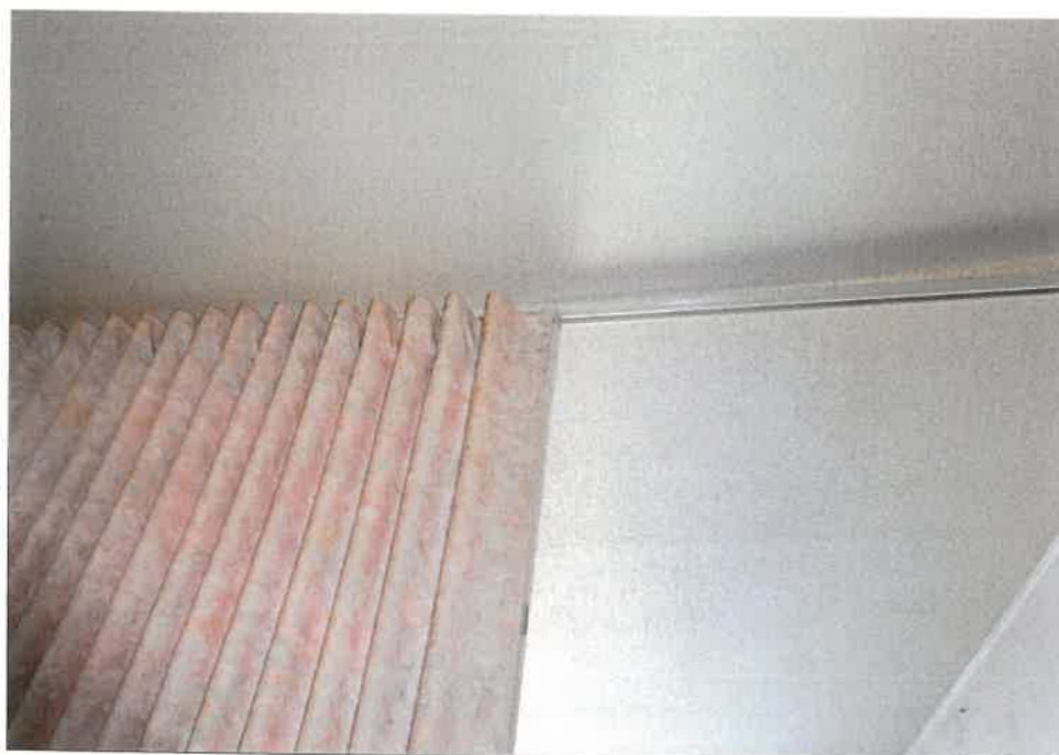
(44) 3階 301号室 居間のアコーディオンカーテンの設置状況
