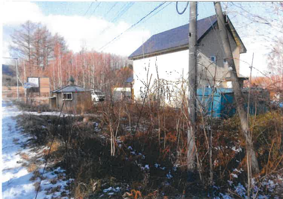
木造仮設物置 スロープ 本建物 スチール製仮設車庫
