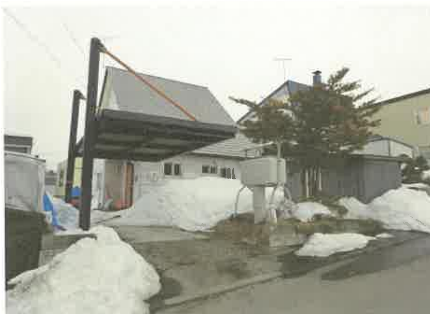
本件建物の外観、本件土地の形状、軽量鉄骨製カーポート
