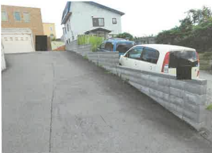
コンクリートブロック塀
