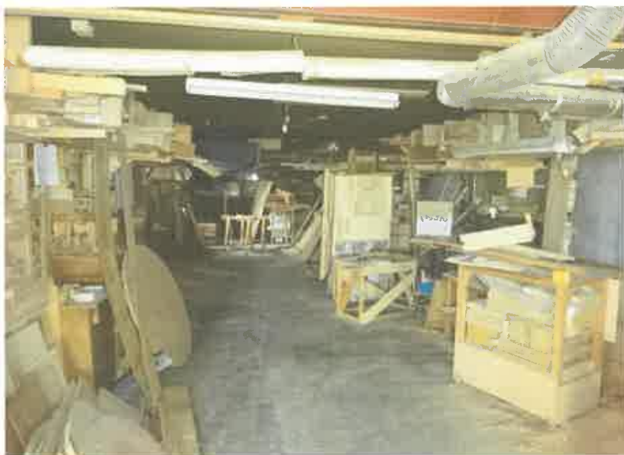
物件4建物（工場・乾燥所）の内部の状況
