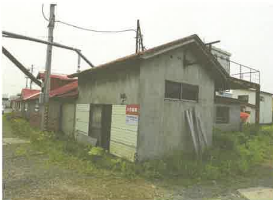
物件3の附属建物（符号3）である物置
