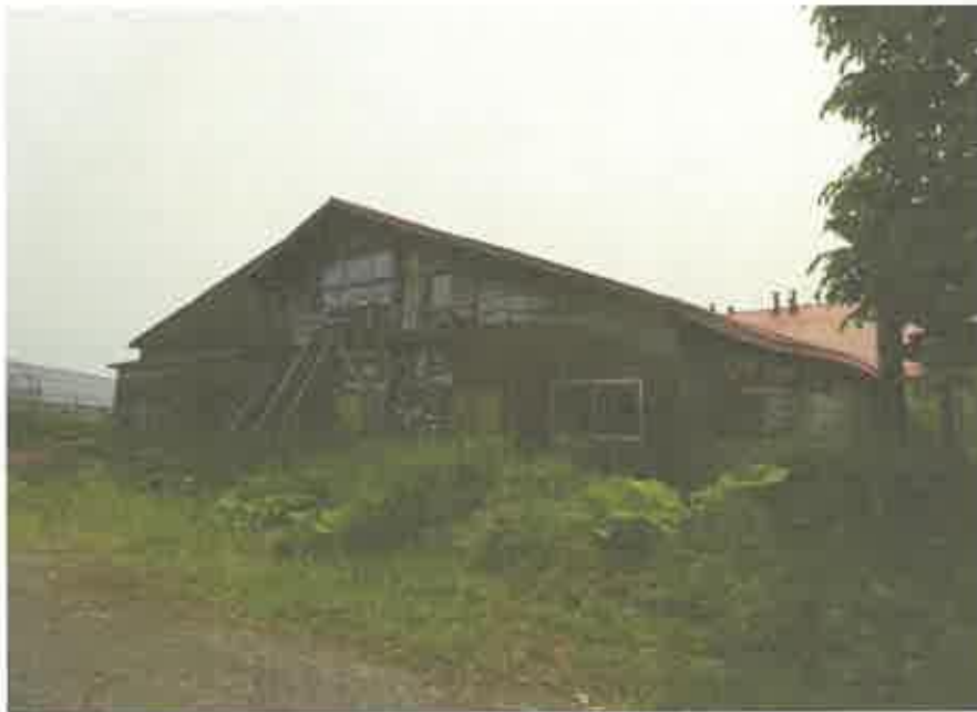
物件4 建物（工場・乾燥所）の外観
