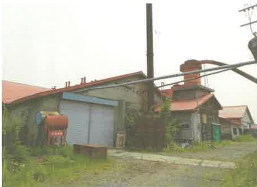
物件4建物（工場・乾燥所）の外観
