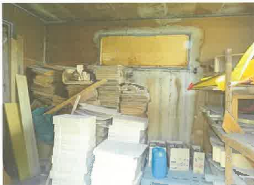
物件3の附属建物（符号3）である物置の内部の状況
