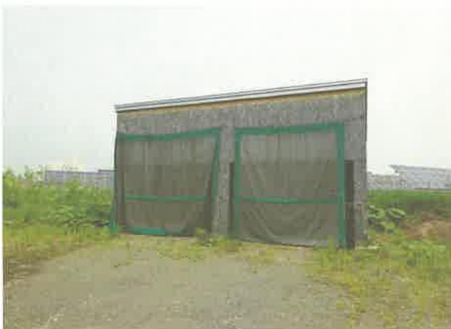
未登記附属建物（木造亜鉛メッキ鋼板葺平家建倉庫）
