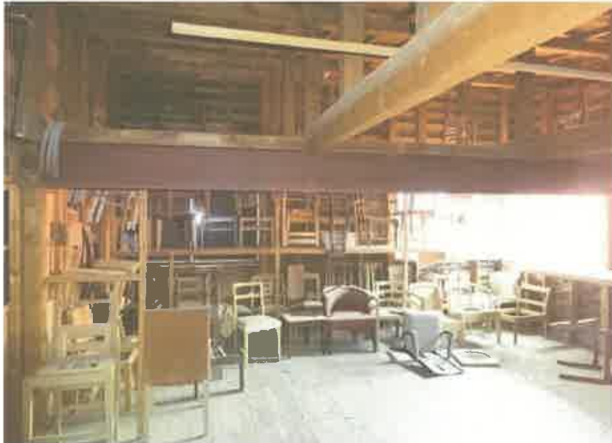
物件4建物（工場・乾燥所）の内部の状況 （同建物の中央部分2階）
