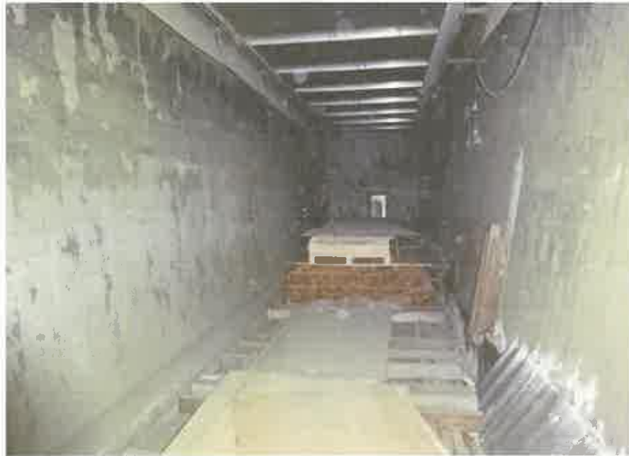
物件4建物（工場・乾燥所）の内部の状況（木材乾燥室の内部）
