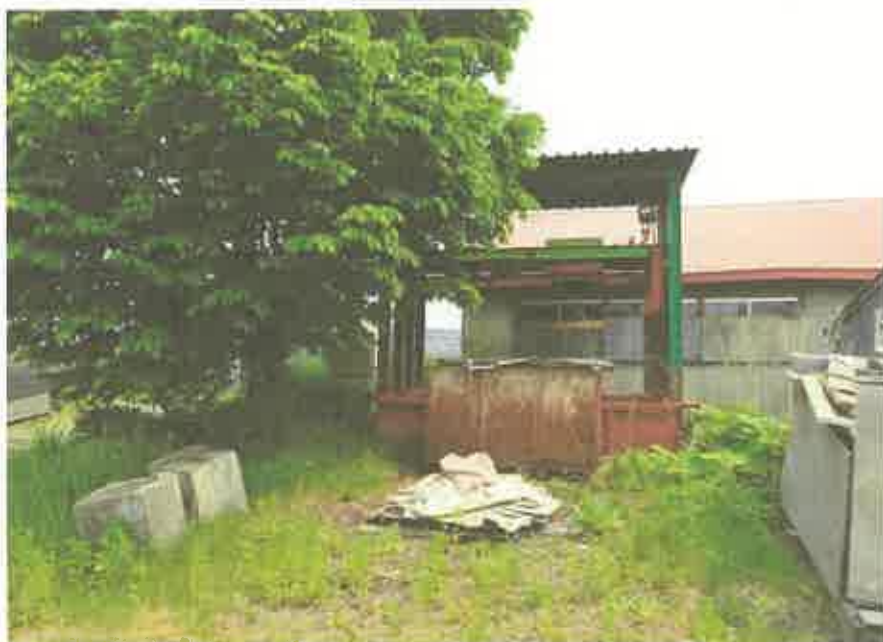
鉄骨造仮設資材置場
