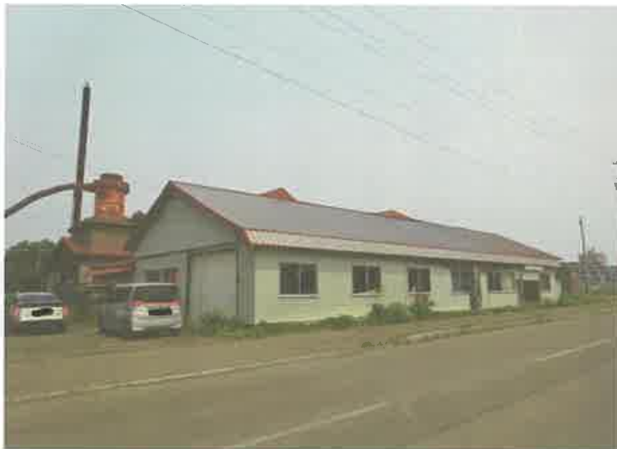
物件4建物（工場・乾燥所）の外観
