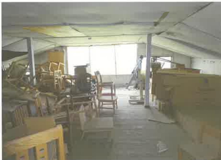
物件4建物（工場・乾燥所）の内部の状況 （同建物の略北西側2階）
