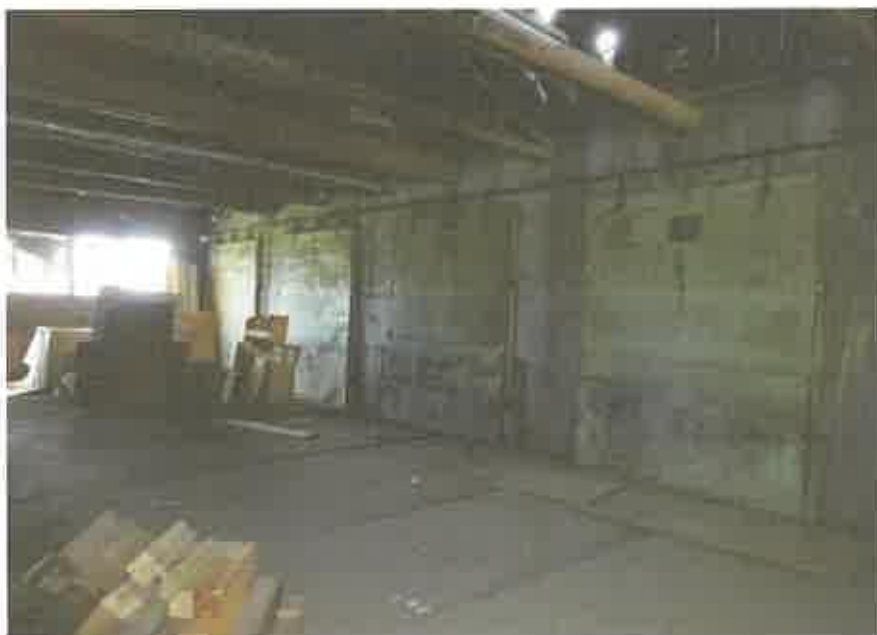
物件4建物（工場・乾燥所）の内部の状況（木材乾燥室）
