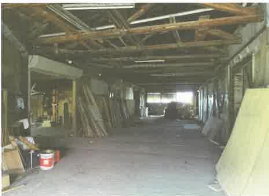
物件4 建物（工場・乾燥所）の内部の状況（作業場）
