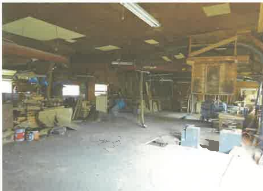
物件3の附属建物（符号2）である倉庫内の状況
