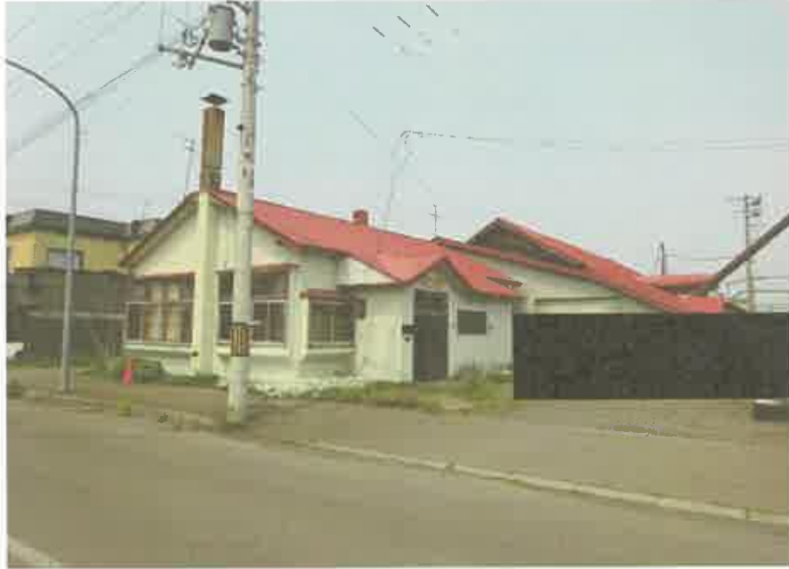
物件3の附属建物（符号1）である事務所
