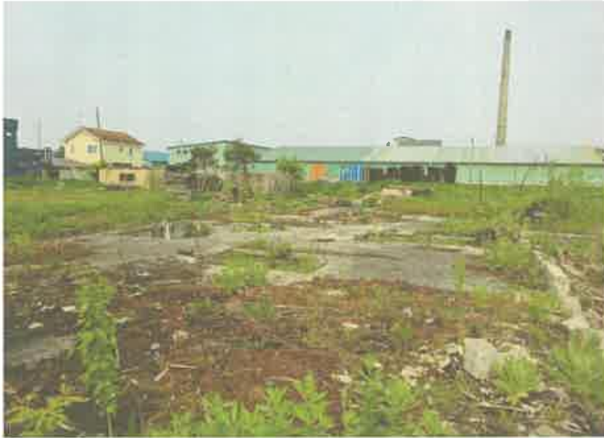
物件3の主である建物の建っていた場所付近の状況 (基礎部分だけが残っている。)
