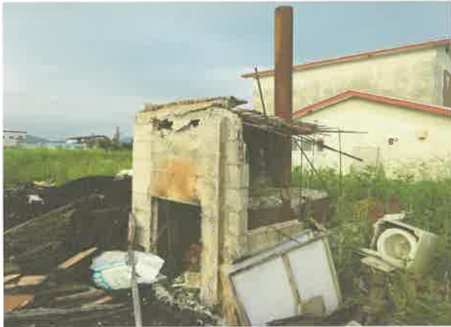
コンクリートブロック造焼却炉
