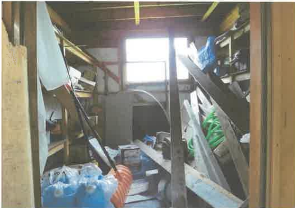
上記物置部分の内部
