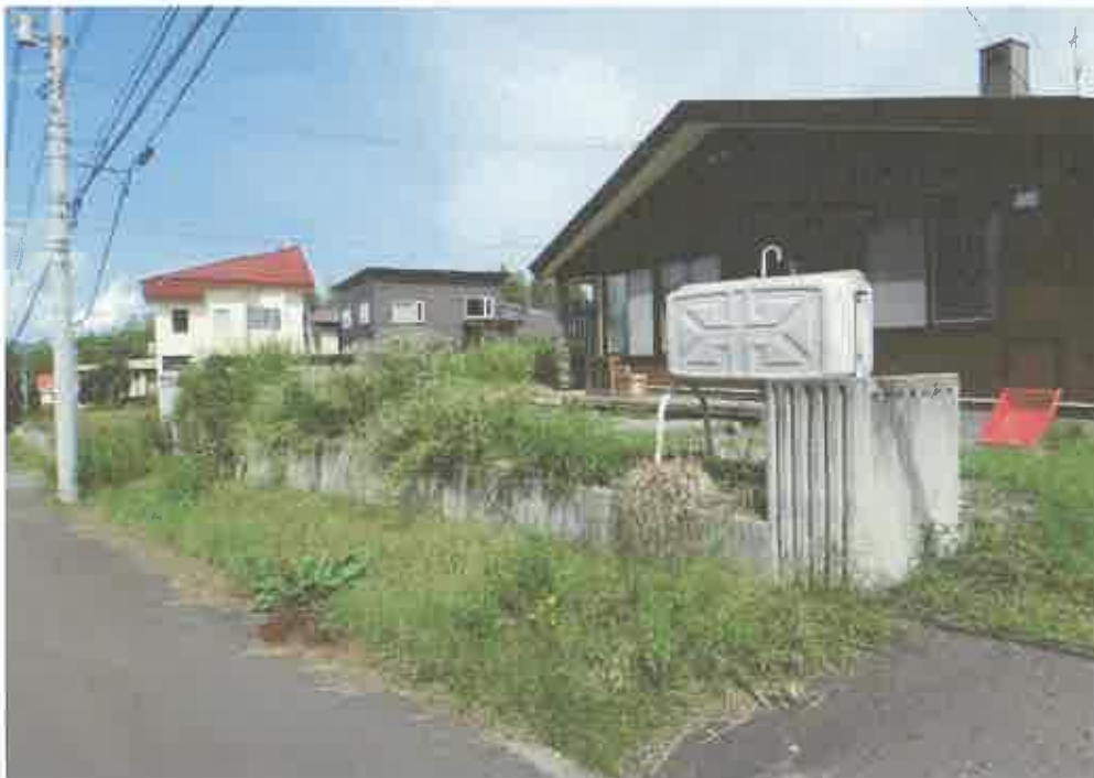
略南西側の鉄筋コンクリート製土留
