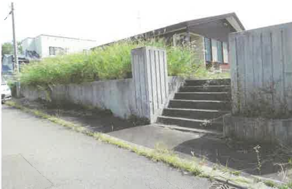
略北西側の鉄筋コンクリート製土留
