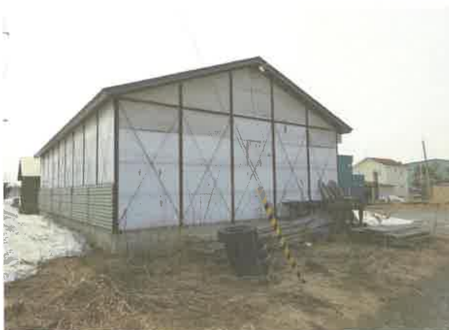
物件5土地及び物件6土地並びに同土地上に跨って建てられている 未登記の目的外建物1（倉庫）
