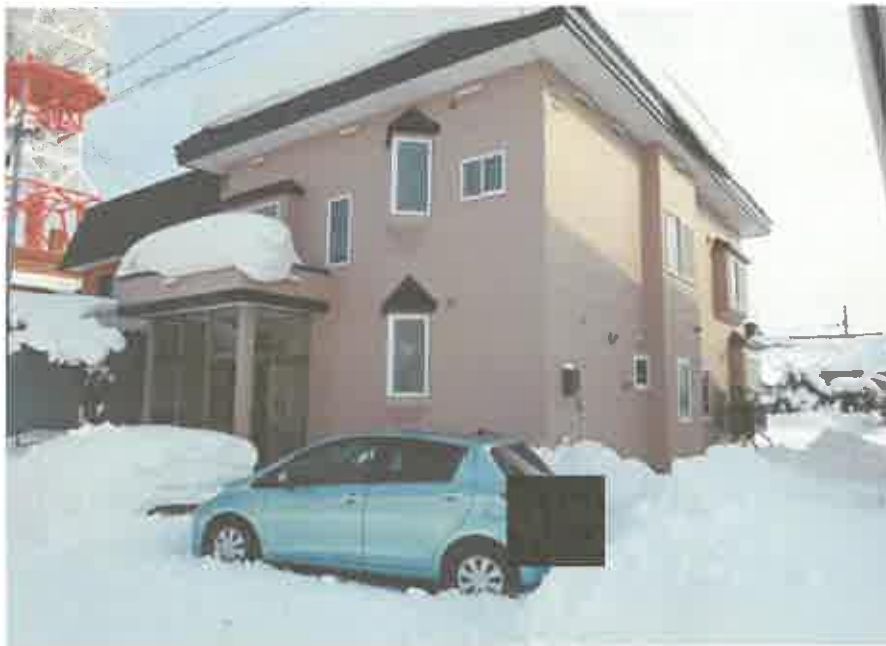
本件土地の形状、目的外建物の外観
