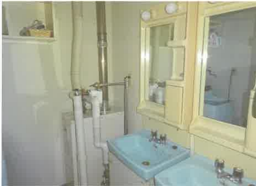
北西側区画（男性従業員居住区）の脱衣室
