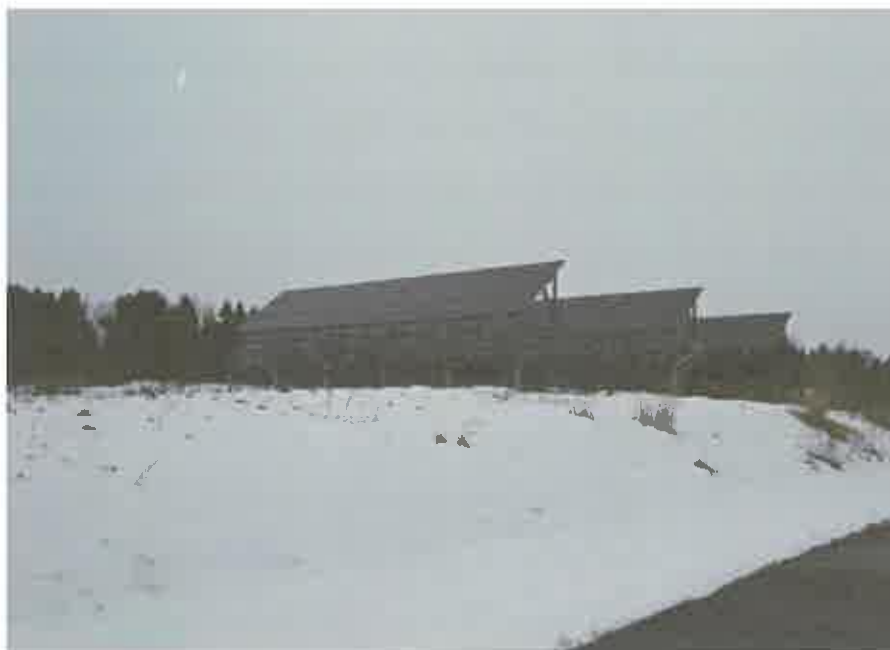
有限会社テトラ所有の太陽光発電設備
