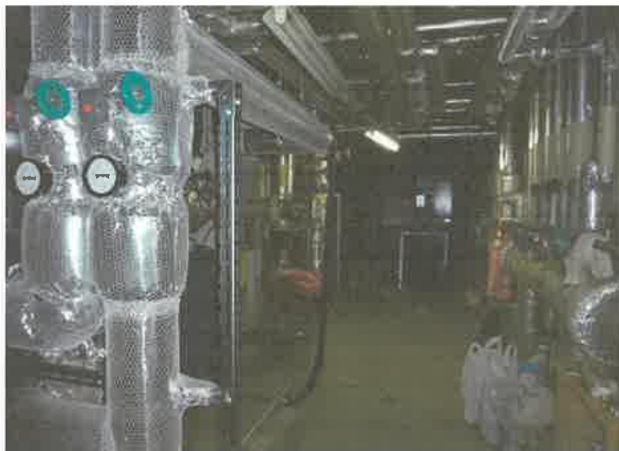
1 階ボイラー室
