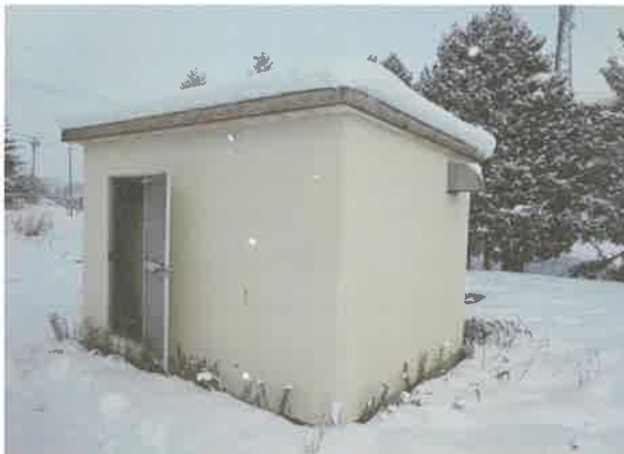
浄化槽ポンプ設備
