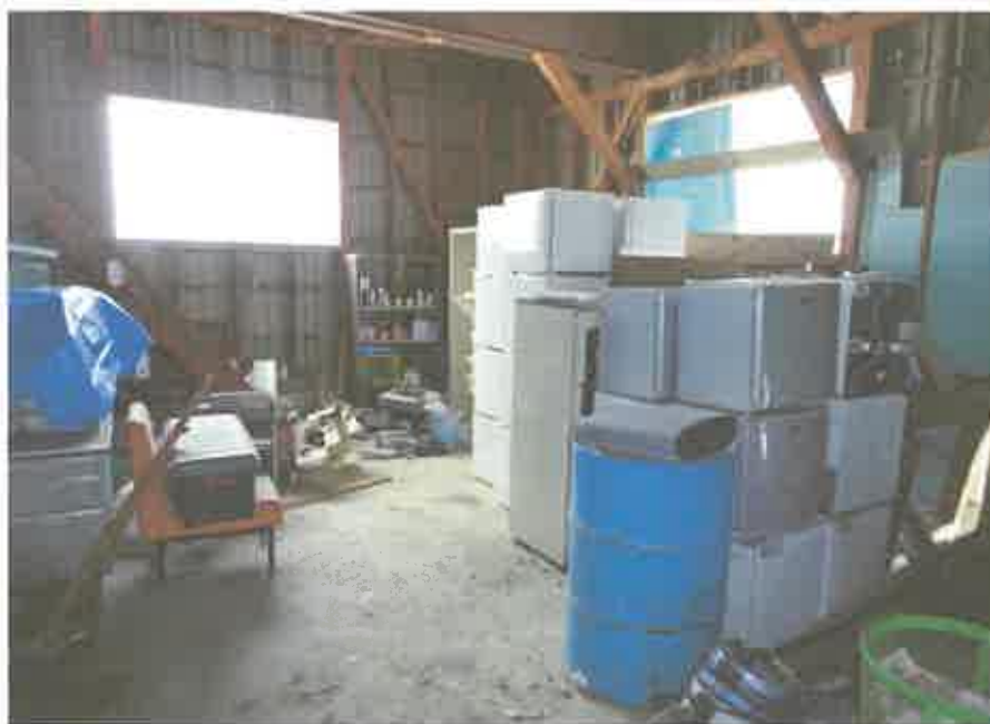
未登記附属建物の内部（木造亜鉛メッキ鋼板葺平家建倉庫）
