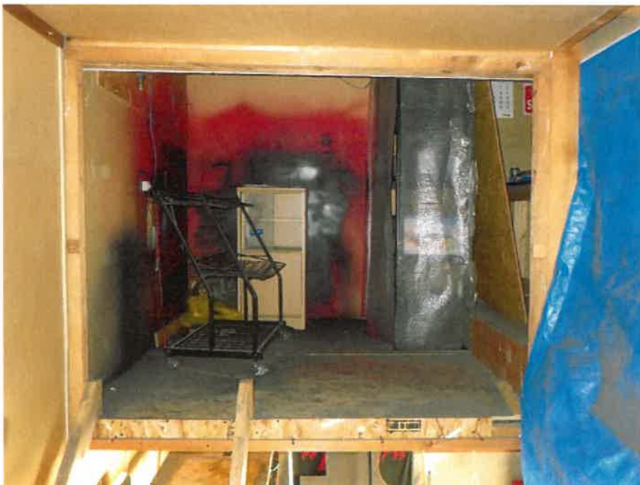
車庫上部の屋根裏物置
