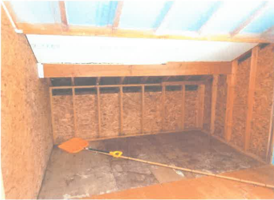
2階洋室Dの小屋裏（部屋に入って左側の部分）
