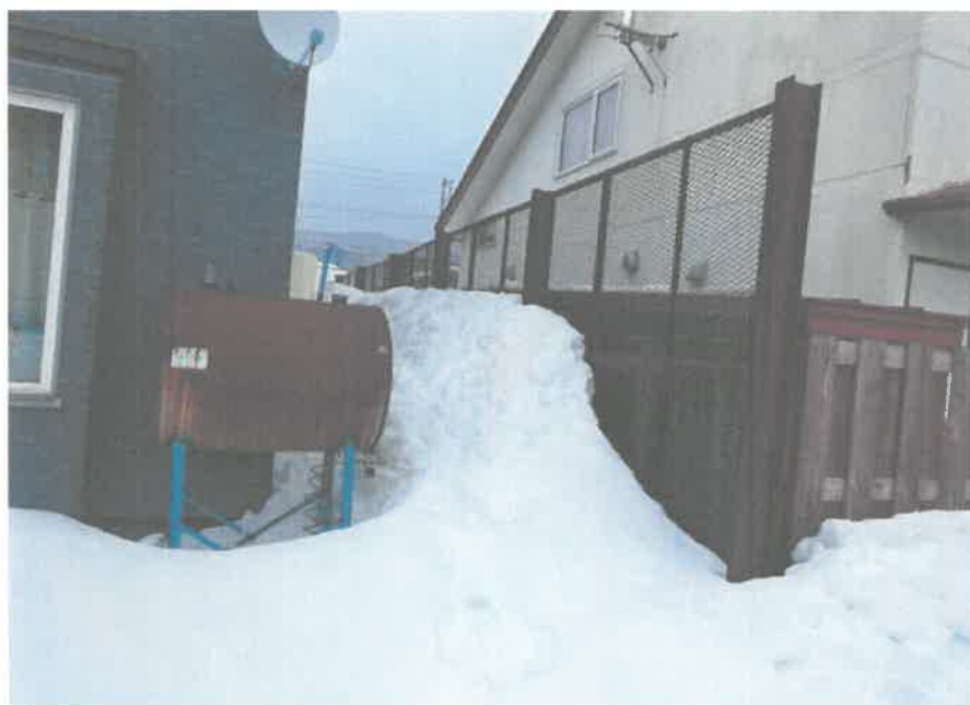
鉄骨製雪止めフェンス
