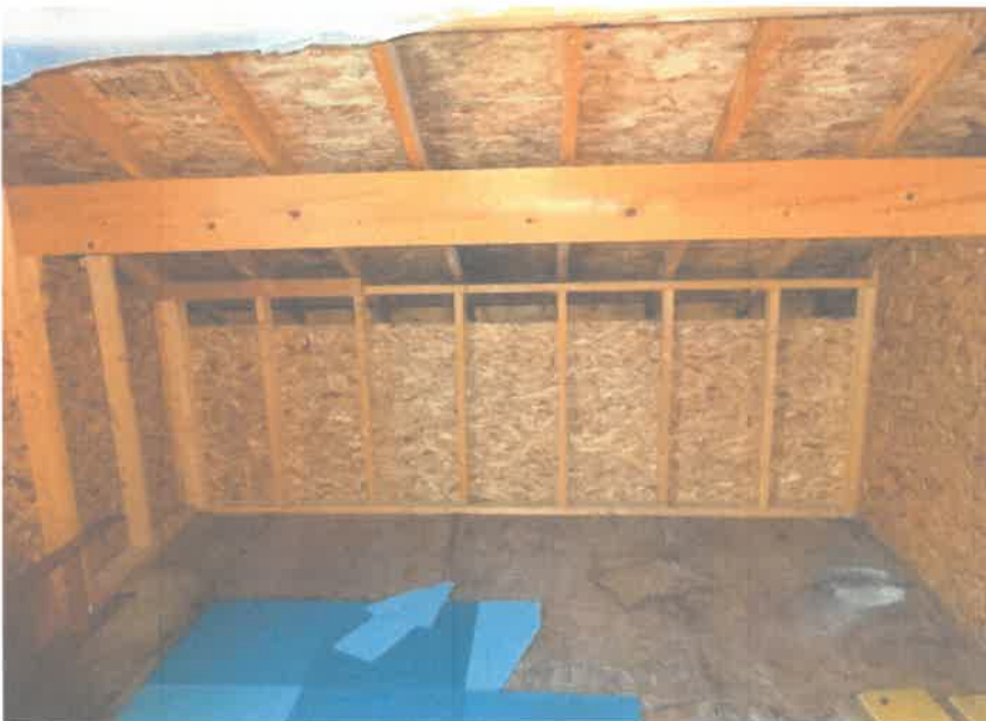
2階洋室Dの小屋裏（部屋に入って右側の部分）
