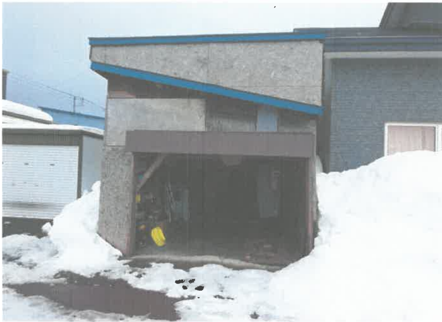
木造仮設車庫
