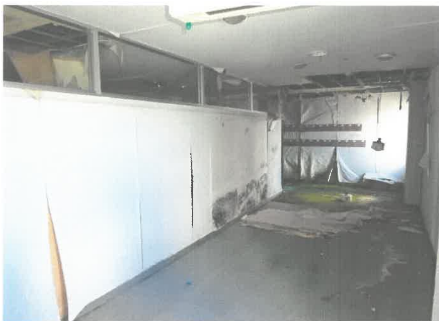
2階サウナのロッカースペース
