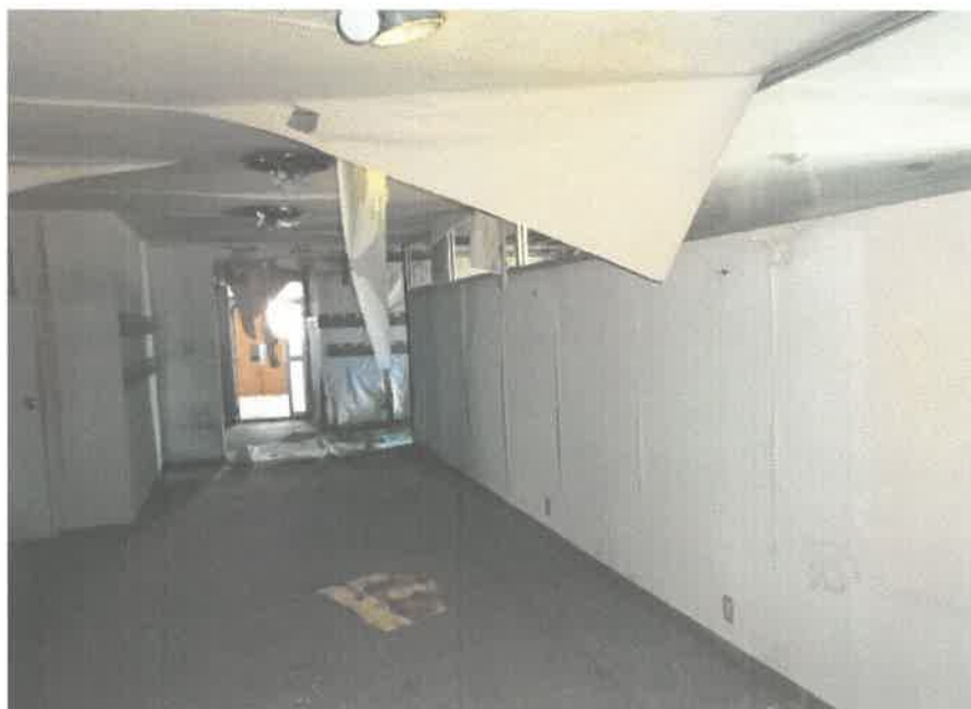
2階サウナのロッカースペース
