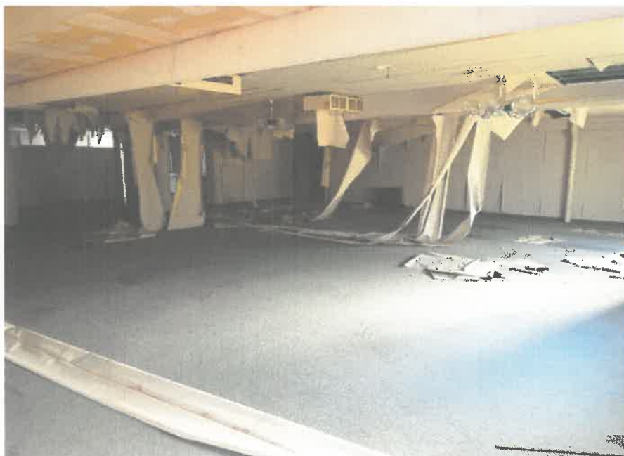
2階サウナの休憩スペース（大部屋）
