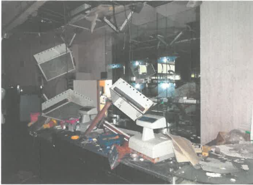
1階パチンコ店のカウンター付近の状況
