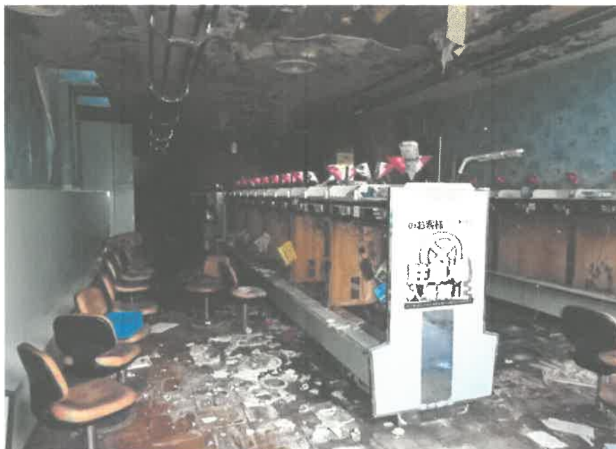
1階パチンコ店のホールの状況
