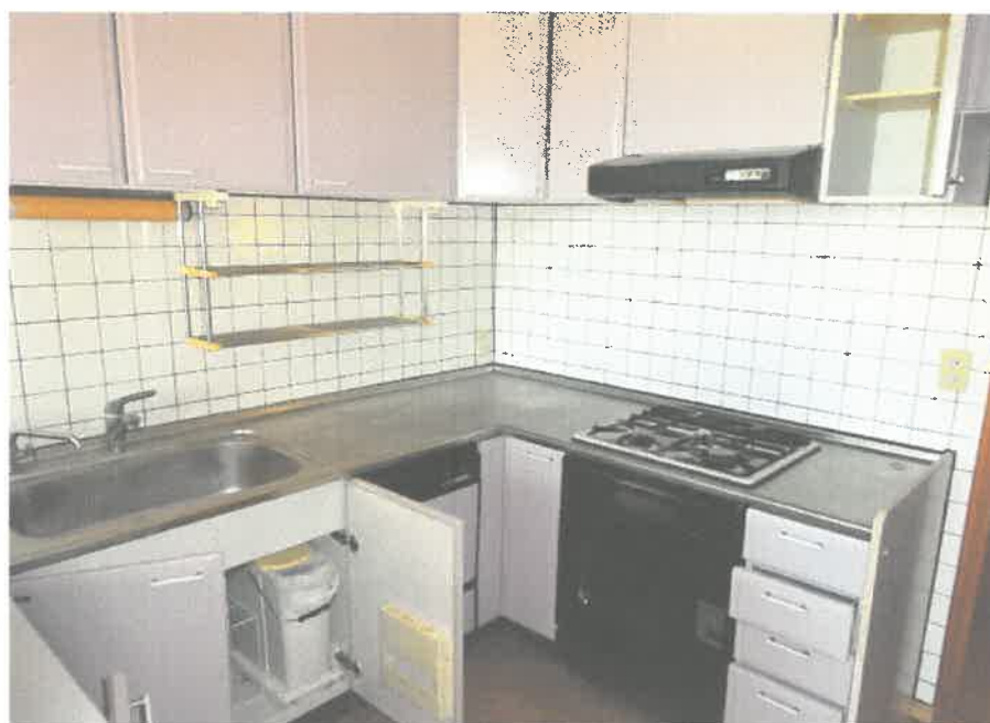
3階居宅部分の台所
