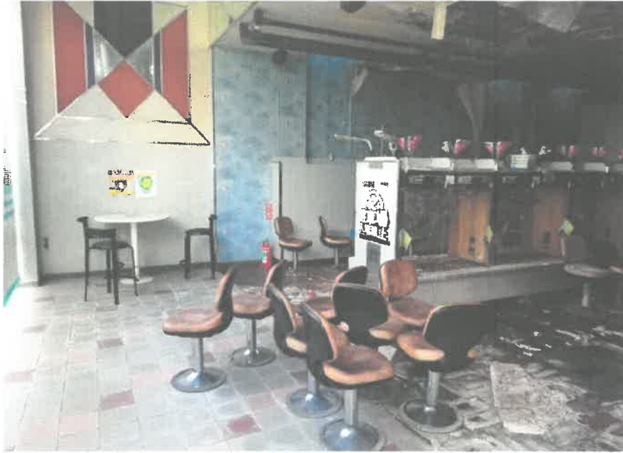
1階パチンコ店のホールの状況
