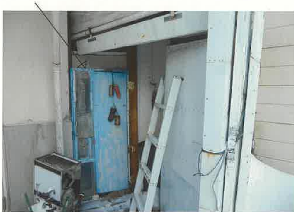
鉄管製鋼板貼仮設通路①（北側より撮影）
