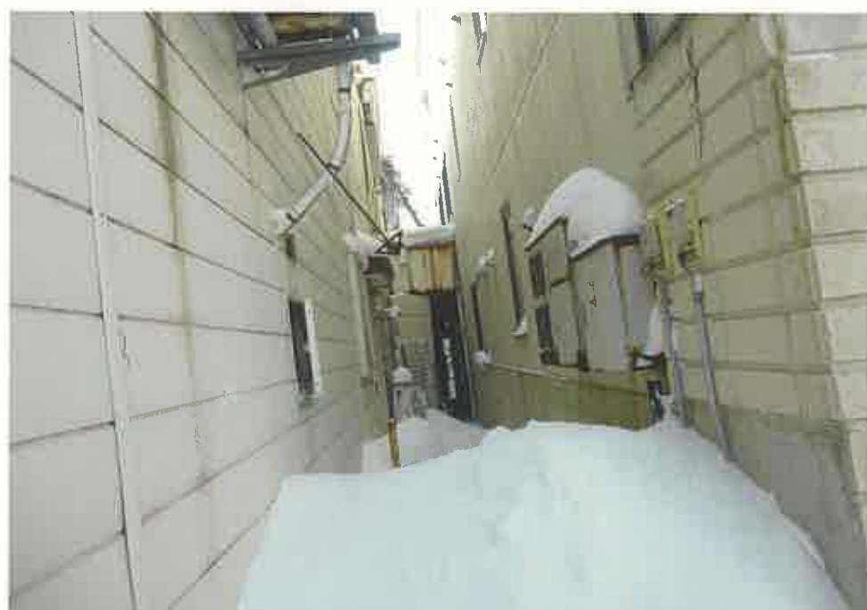
鉄管製鋼板貼仮設通路②（南東側より撮影）
