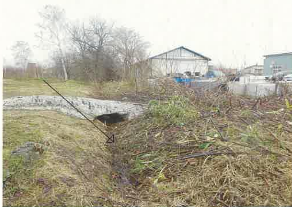
物件 3 南西側の状況
