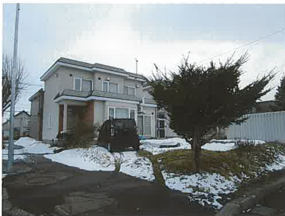
全景(北西側から撮影)
