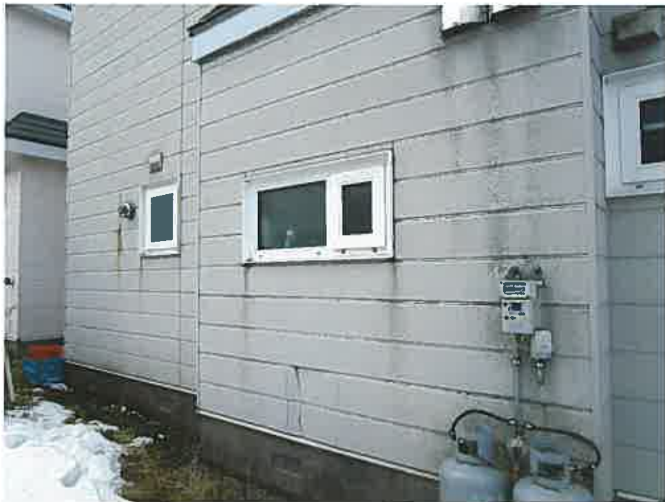
北東側の外壁
