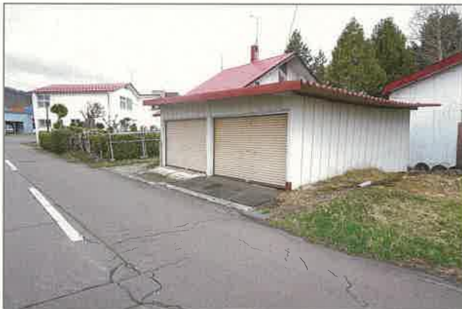
㊦物件5附属建物
