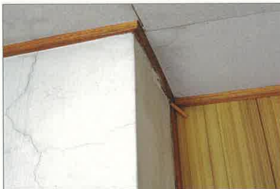
③②物件5(煙突付近の壁の状況)
