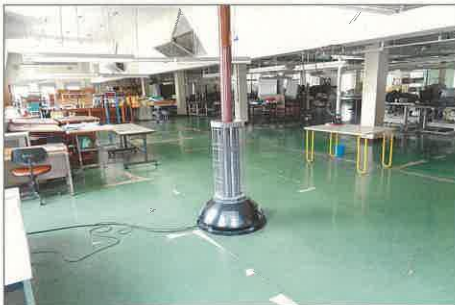
②①物件4(2階作業場)
