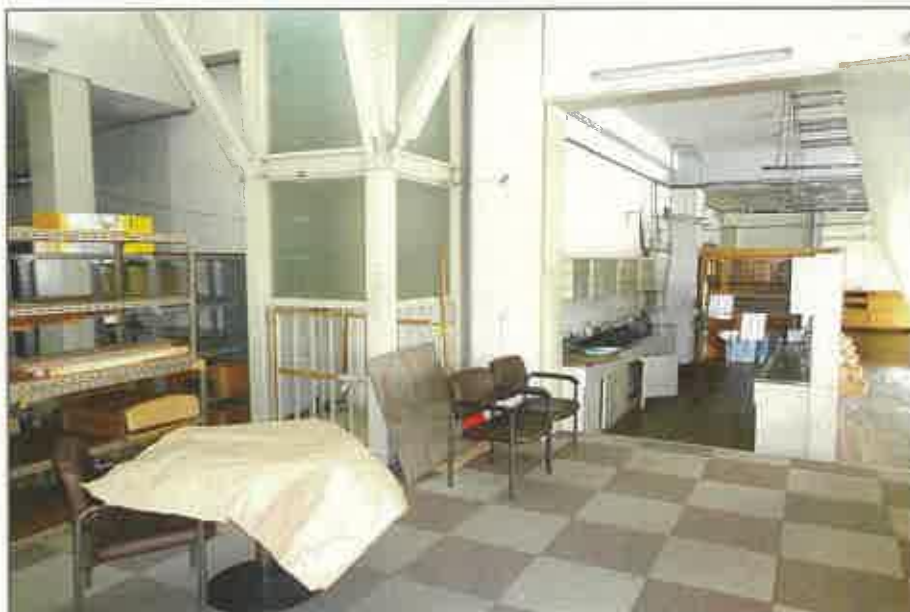
②④物件4(2階階段室)
