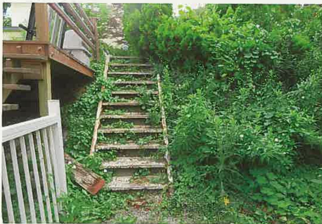
13 法面部分金属製階段
