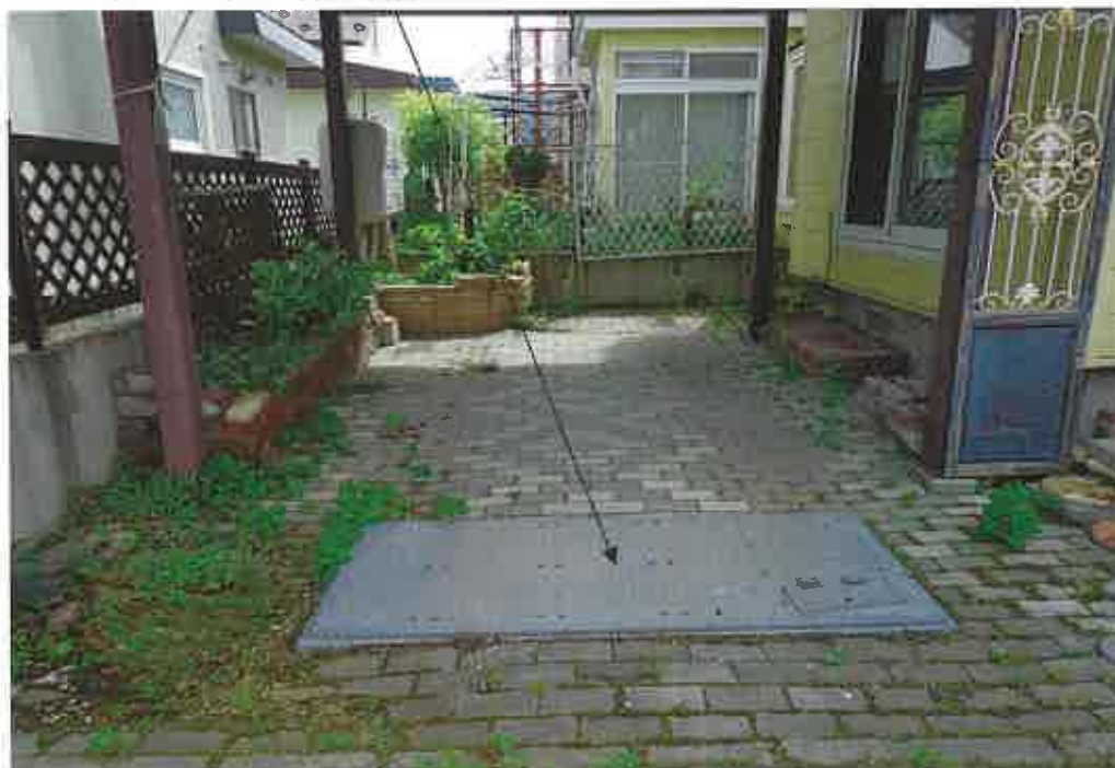
カーポート及び融雪槽
