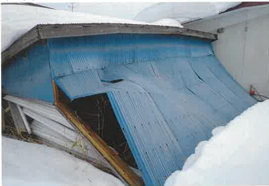
木造仮設車庫
