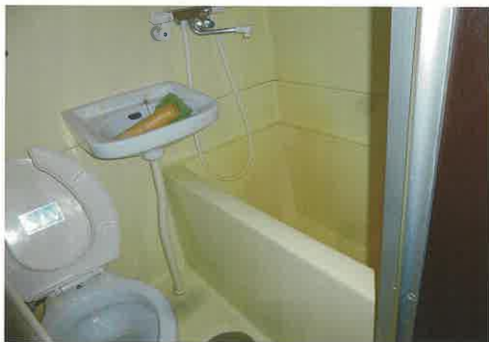
403号室 トイレ・洗面台・浴室
