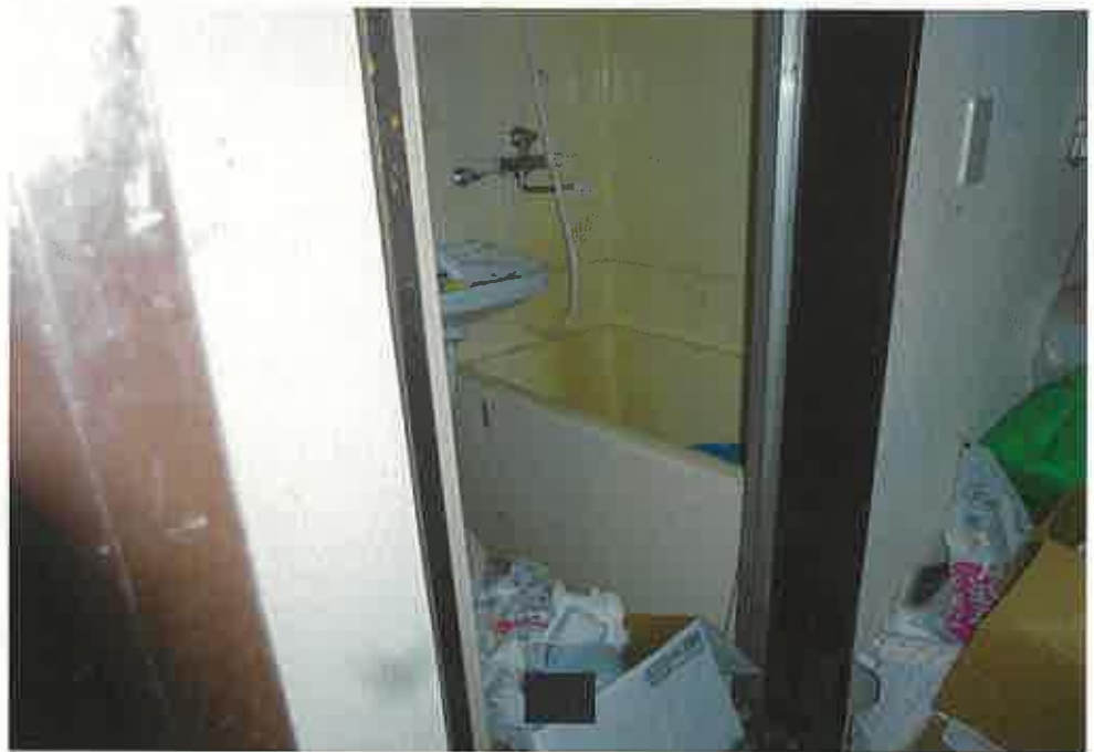
206号室 トイレ・洗面台・浴室
