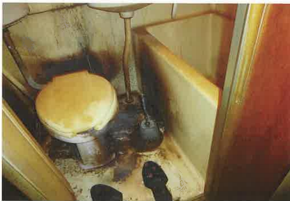
106号室 トイレ・洗面台・浴室
