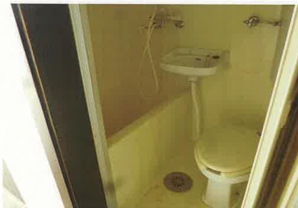
205号室 トイレ・洗面台・浴室
