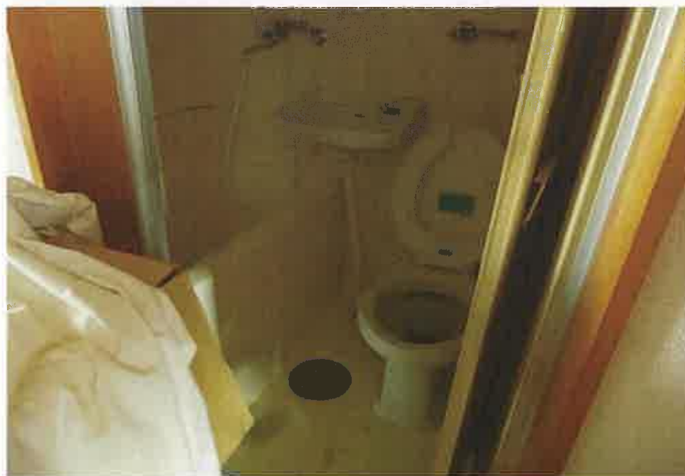
302号室 トイレ・洗面台・浴室
