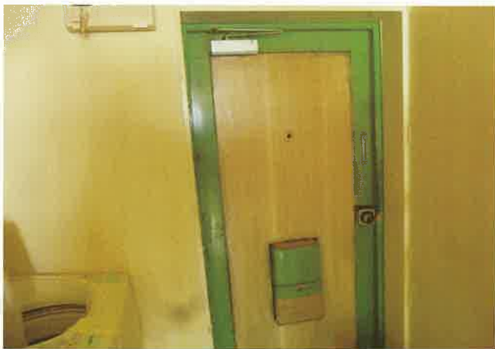
203号室 玄関ドアの状況
