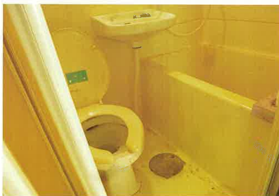
103号室 トイレ・洗面台・浴室
