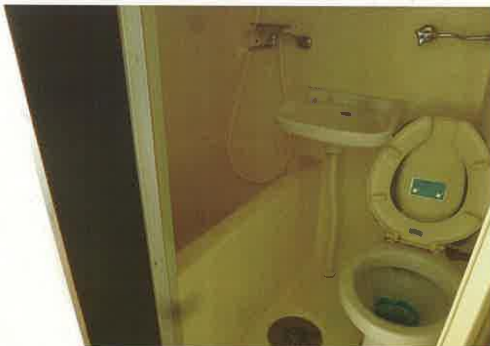
202号室 トイレ・洗面台・浴室
