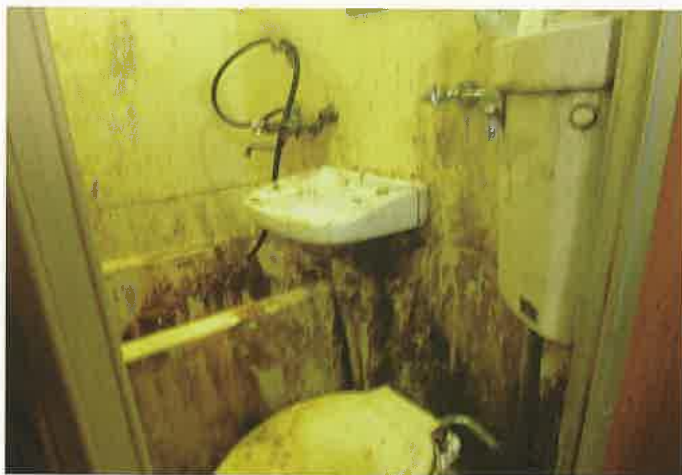
301号室 トイレ・洗面台・浴室
