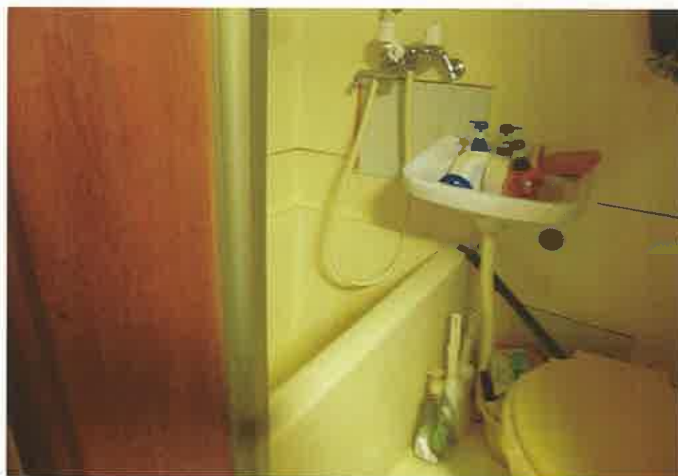
305号室 トイレ・洗面台・浴室
