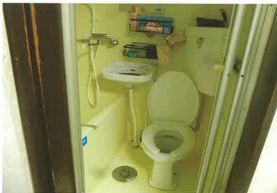
105号室 トイレ・洗面台・浴室
