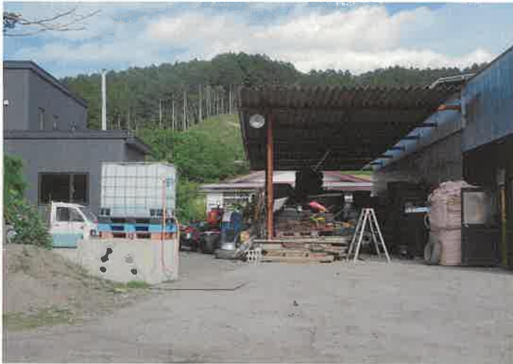
5 鉄骨製目的外仮設下屋等（有限会社安田工業の占有状況）
