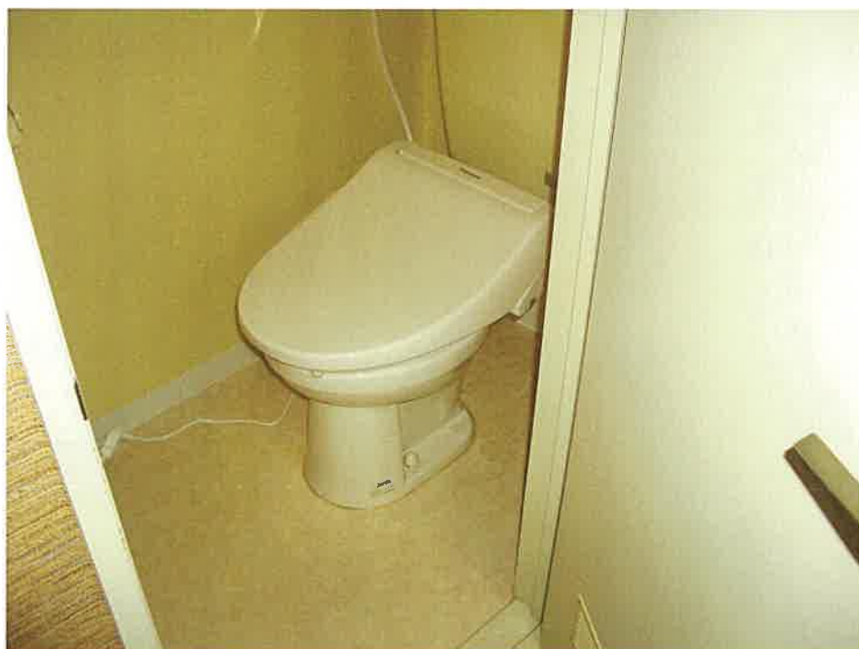
303号室(空室)のトイレ
