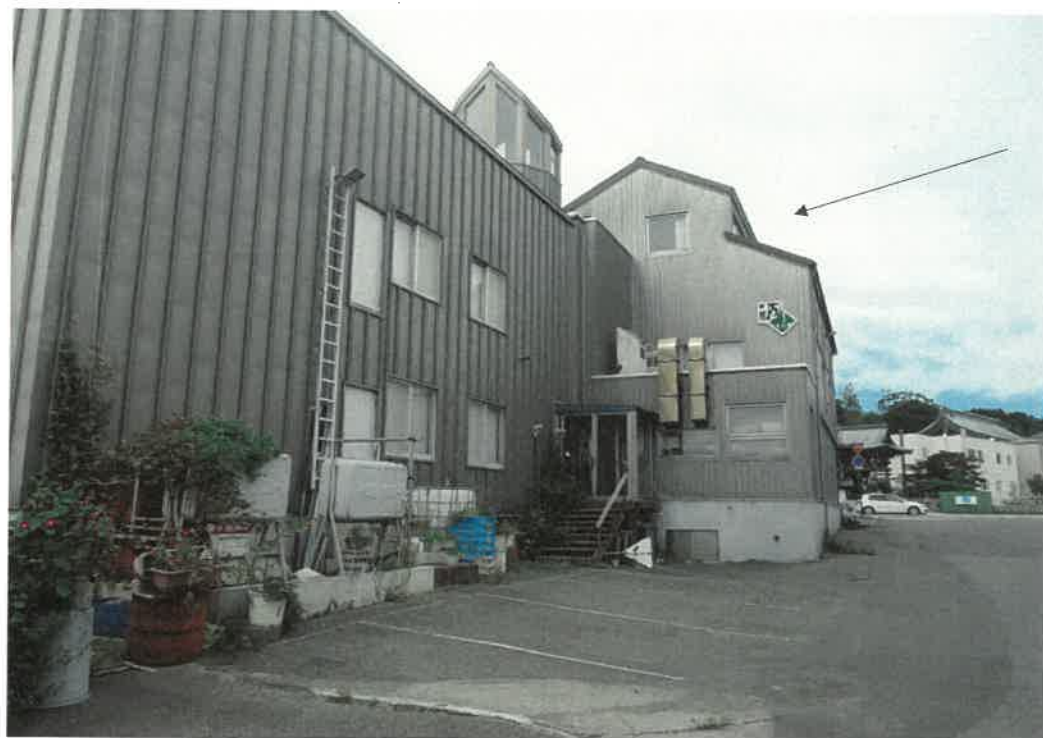
2 建物外観全景（東側から撮影）
