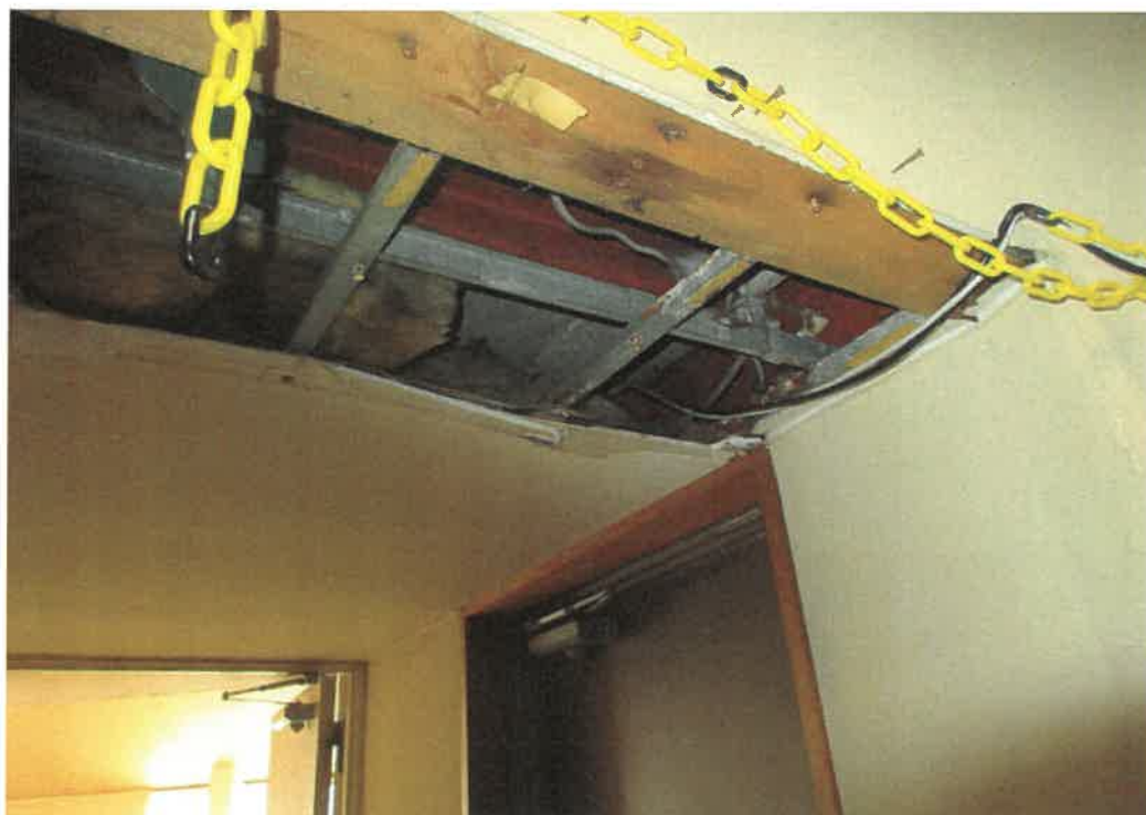
16 3階通路天井（損壊状況）
